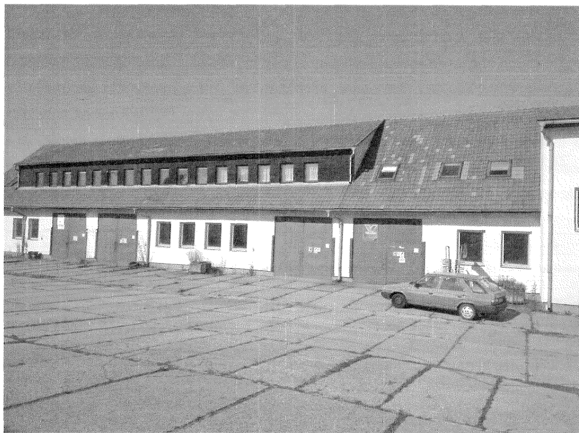
Obrázek 2: Provozní budova, dílny
