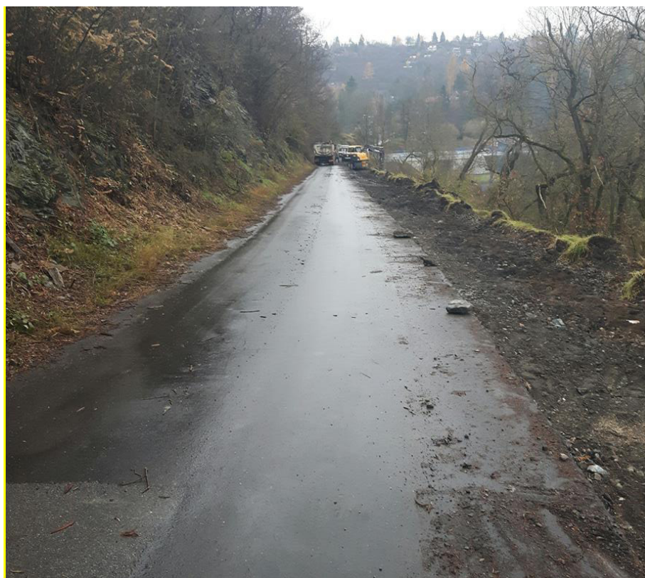
Obrázek 5 - Pohled na skalní stěnu
