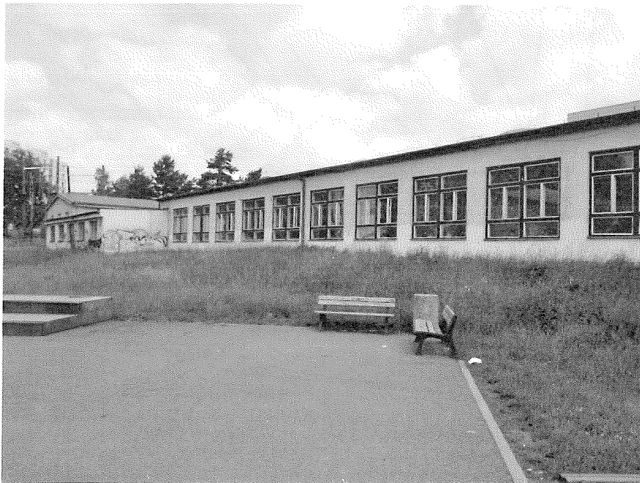
Obrázek 2: Zadní pohled na budovu
