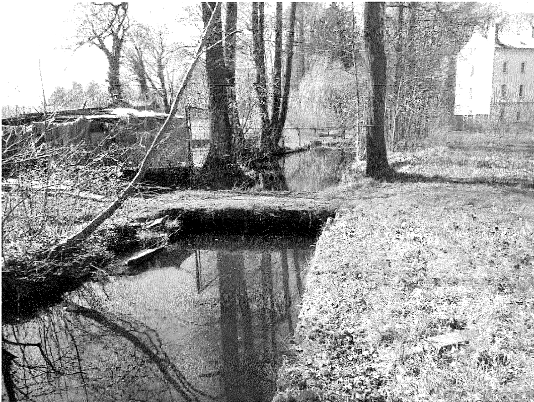
Obrázek 4: Nad vzdouvacím zařízením (proti proudu)
