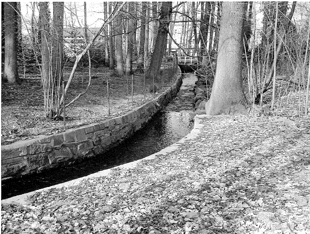
Obrázek 7: Lesní potok ř.km 0,400 - 0,490 (po proudu)
