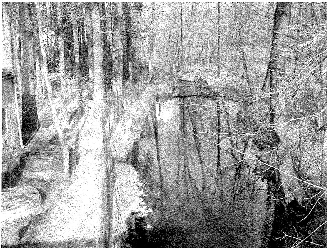
Obrázek 9: Nad vzdouvacím zařízením v ř.km 0,500 - nalevo odběrné místo Kamenoprůmyslových závodů
