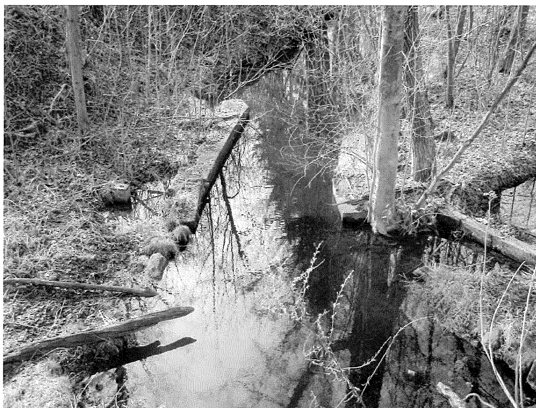
Obrázek 10: Zbytky opevnění v ř.km 0,560
