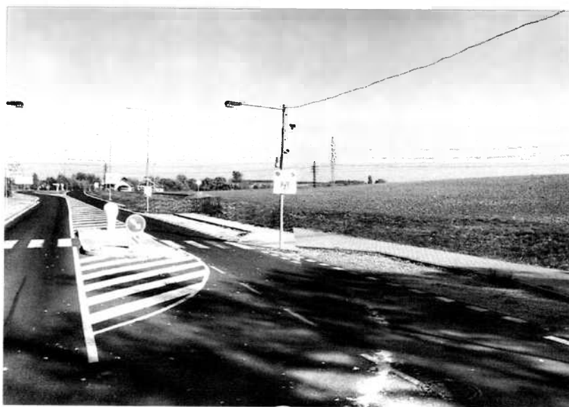
Obrázek 4- umístění zařízení se stálým napájením - na sloupu společně s SDZ IP6 ( současné umístění) - Sendražice u hřbitova
