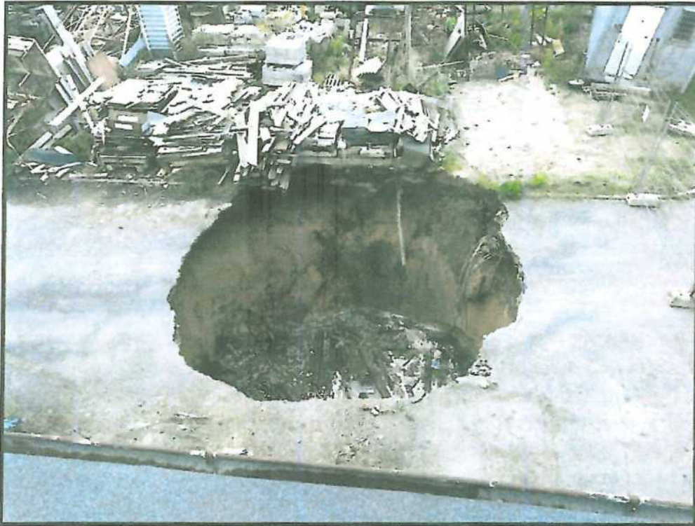
Foto č. 2 propadu do jámy - jižním směrem (4.9.2020)
