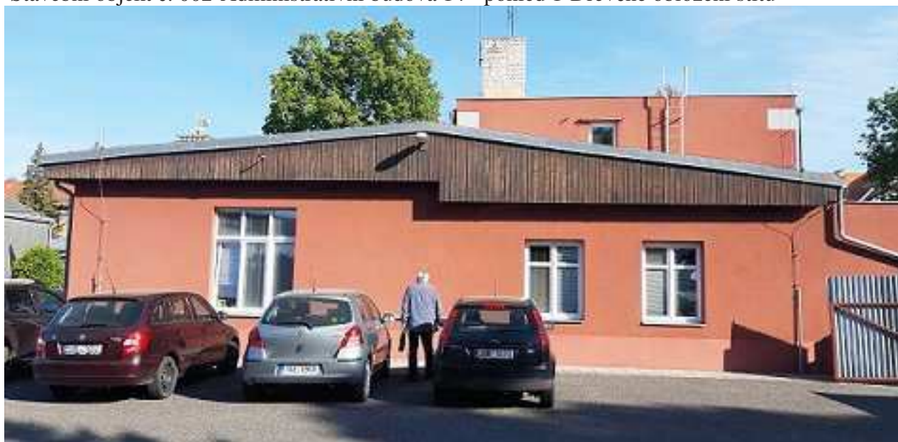
Stavební objekt č. 002-Administrativní budova 14 - pohled 1-Dřevěné obložení štítu
