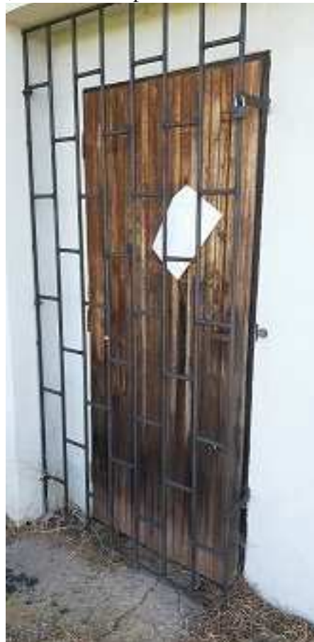
Stavební objekt č. 089 - kinosál, boční dveře-pracoviště VÚ 3255
