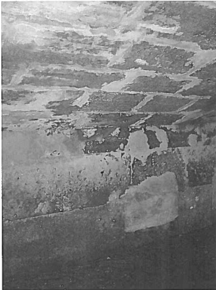
Vyspravená opěra a spárování NK
