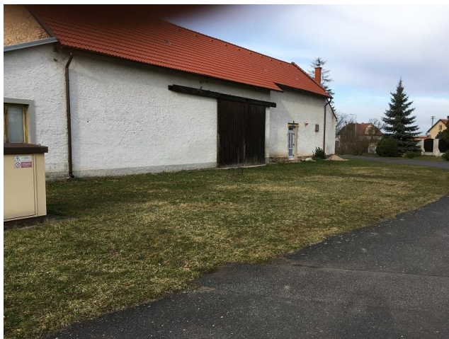
obr. 6 – stanoviště pro strom č. 11
