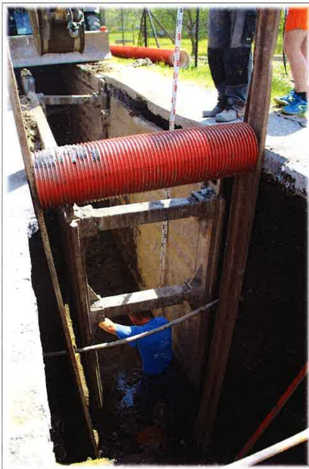
Obrázek 2 a 3 Místo výkopu č.2
