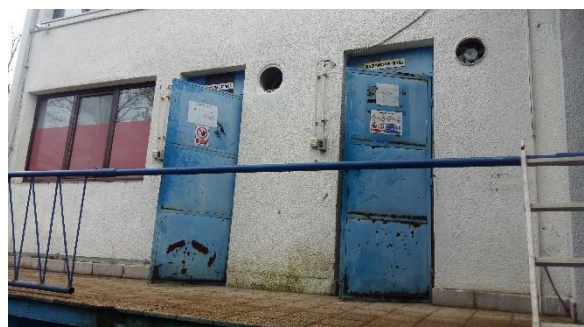
Obr. 13 Fotografie z místního šetření, pohled na stávající místnosti pro dezinfekci vody (chlórové hospodářství)
