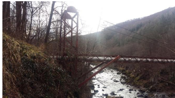
Obr. 9 Fotografie z místního šetření, pohled na potrubí přes řeku Velika Usora
