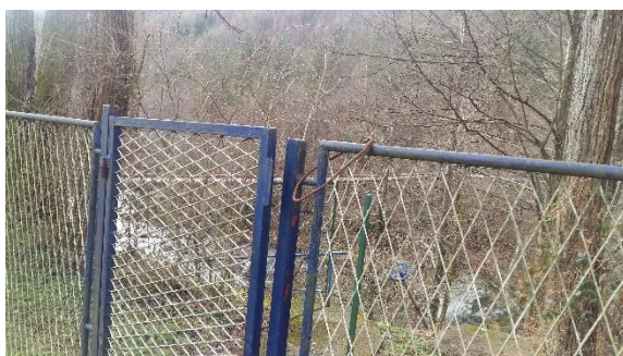
Obr. 12 Fotografie z místního šetření, pohled na přístup k odběrnému objektu v řece Usora
