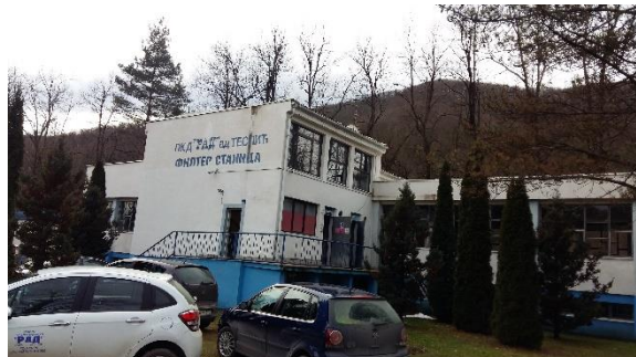
Obr. 3 Fotografie z místního šetření, pohled na PPPV
