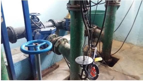
Obr. 14 Fotografie z místního šetření, čerpací stanice v armaturní části PPPV
