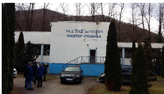
Obr. 4 Fotografie z místního šetření, pohled na PPPV
