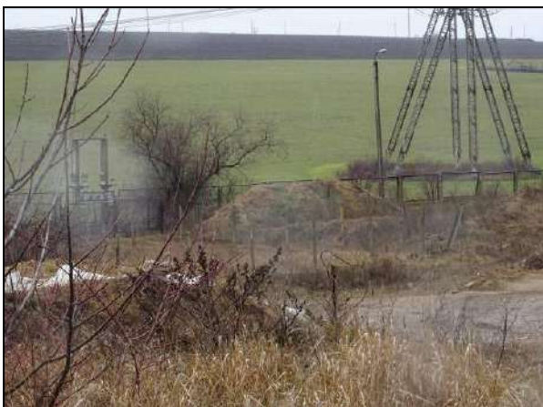
Pohled na zemní úložiště (zemina, kondenzátory) při západním okraji areálu.
