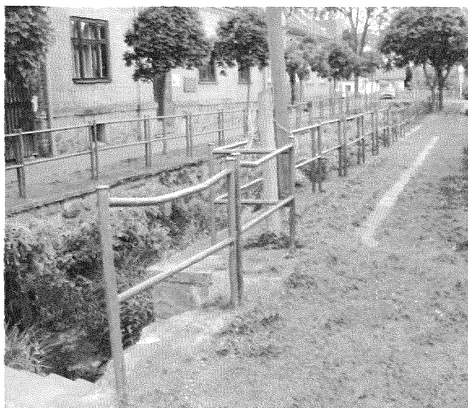
Pohled na rozvodný sloup a jeho poloha u nábřežní zdi
