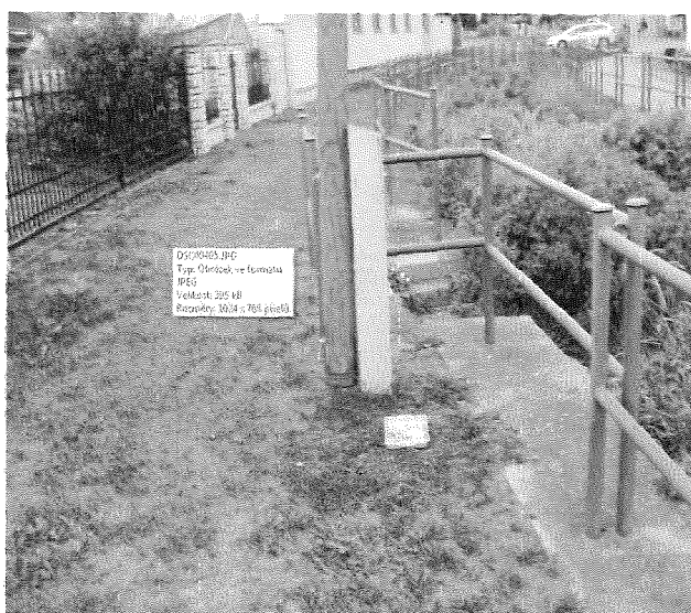
Pohled na průběžný sloup a jeho poloha u nábrežní zdi
