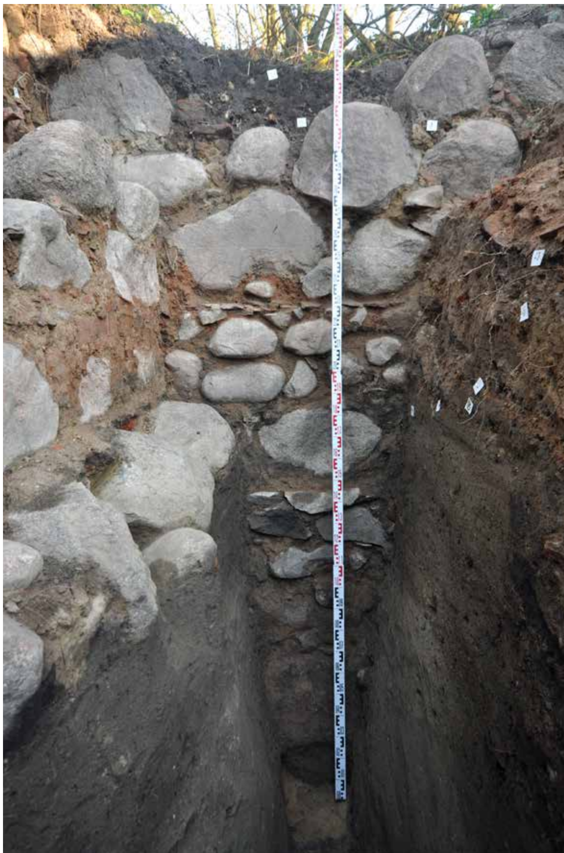
Obr. 10. Partia fundamentowa i cokołowa ściany domu konwentu odsłonięta w wykopie nr 1. Fot. B. Wasik. – Abb. 10. Die in der Sonde Nr. 1 entdeckte Fundament- und Sockelpartie des Konventshausesmauerwerks. Foto B. Wasik.
