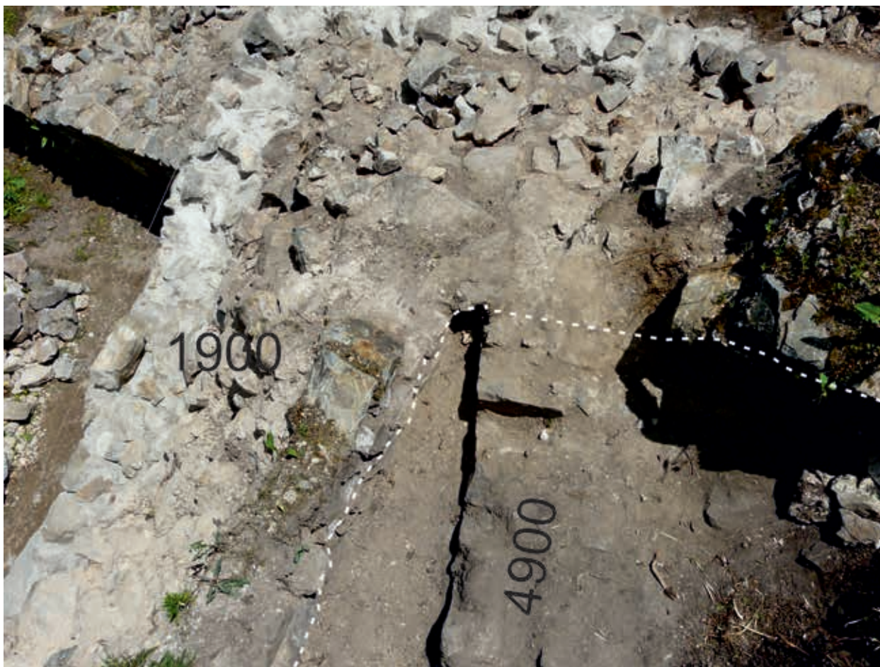
Obr. 24. Rabštejnek (okr. Chrudim). Sonda 4/2017. Detail styku staršího zdiva 4900 (vpravo) a mladšího zdiva věže (1900). Pohled od severozápadu. Foto J. Musil. – Abb. 24. Rabstein (Bez. Chrudim). Sonde 4/2017. Detail des Kontaktes des älteren Mauerwerkes 4900 (rechts) und des jüngeren Mauerwerkes des Turmes (1900). Ansicht vom Nordwesten. Foto J. Musil.
