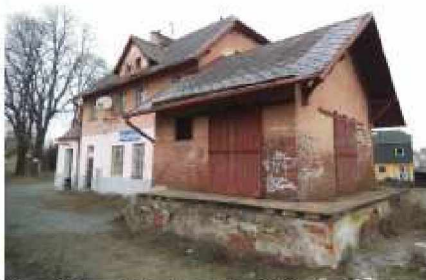
Obr. č.3 - Pohled na skladiště
