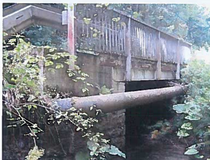
Pohled na pravou část mostu
