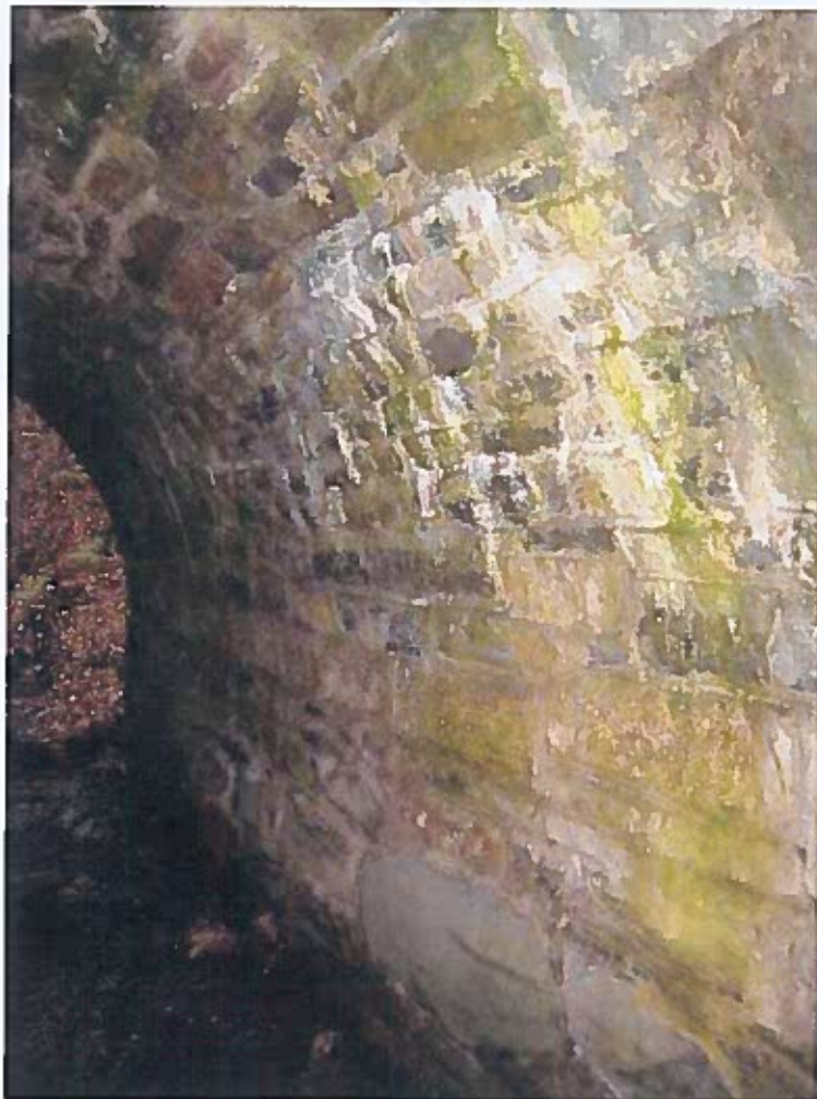
Pohled na pravou část klenby od výtoku
