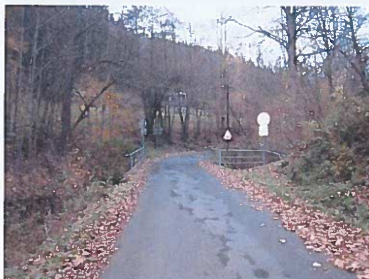
Celkový pohled po směru staničení
