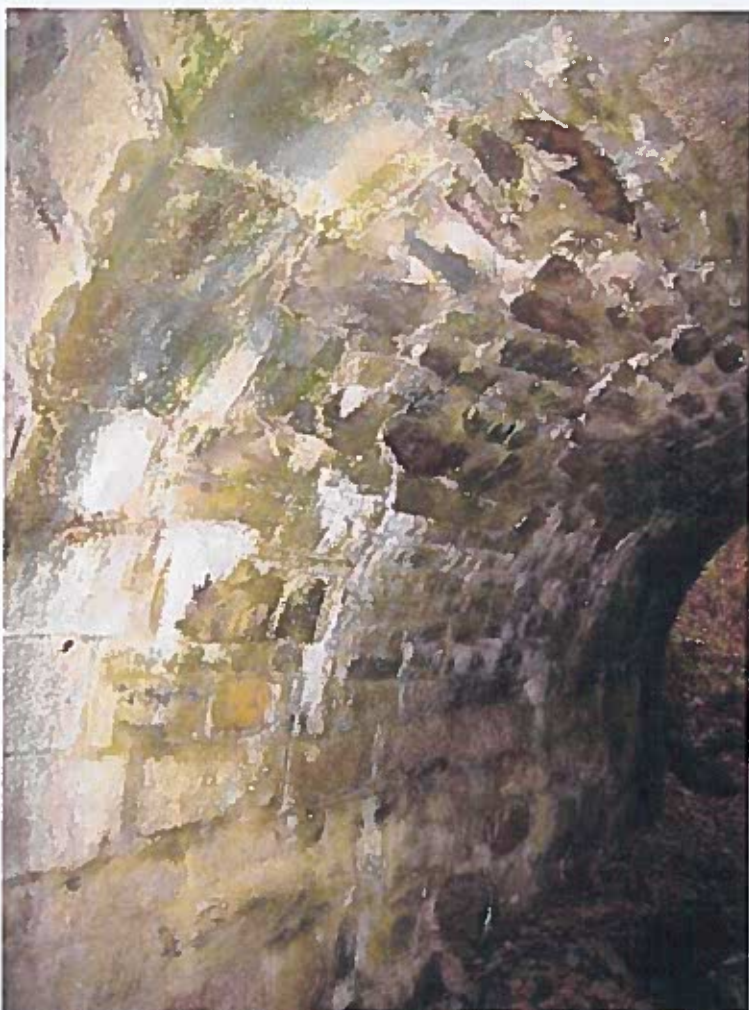
Pohled na levou část klenby od výtoku
