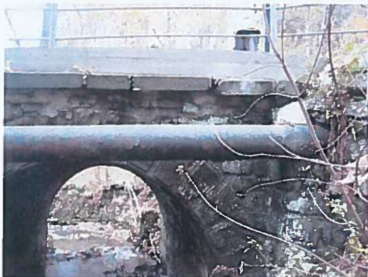
Pohled na pravé křídlo na vtoku
