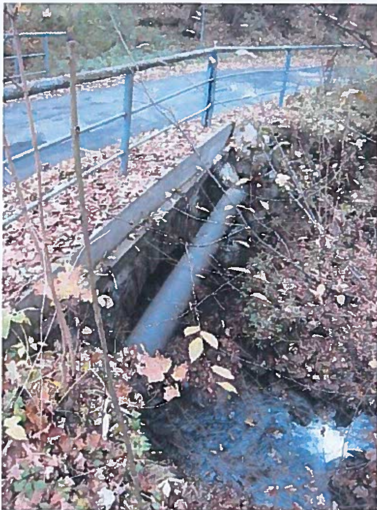
Pohled na římsu na vtoku ve směru staničení
