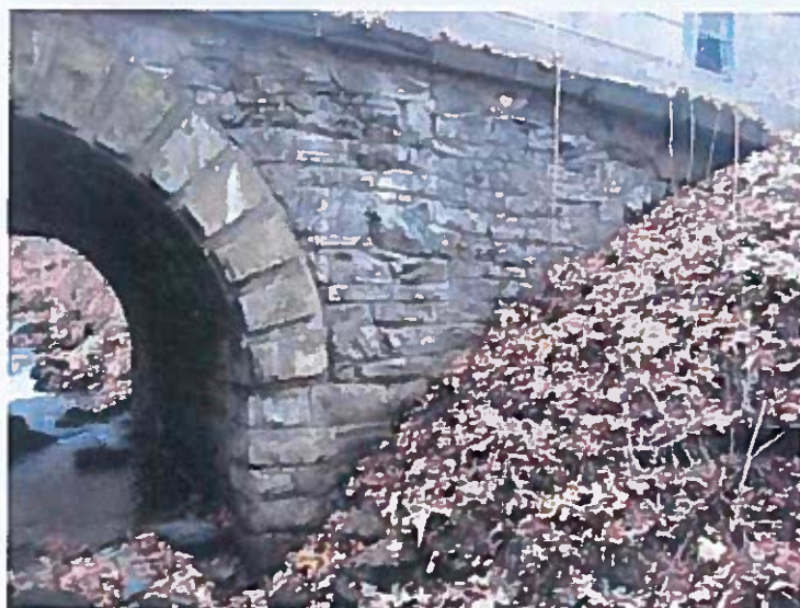
Pohled na pravé křídlo na výtoku
