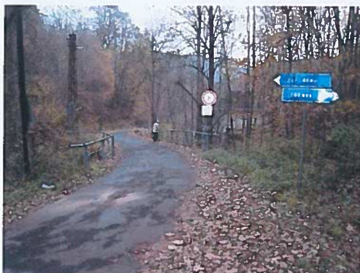
Celkový pohled proti směru staničení
