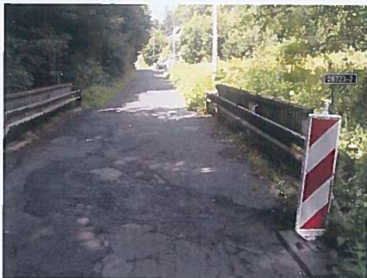
Pohled na most po směru staničení
