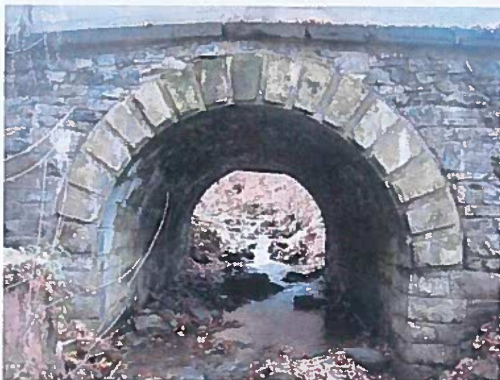
Pohled na čelo výtoku
