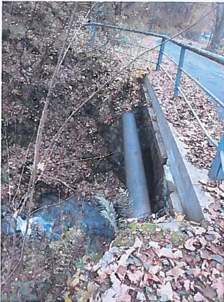
Pohled na římsu na vtoku proti směru staničení
