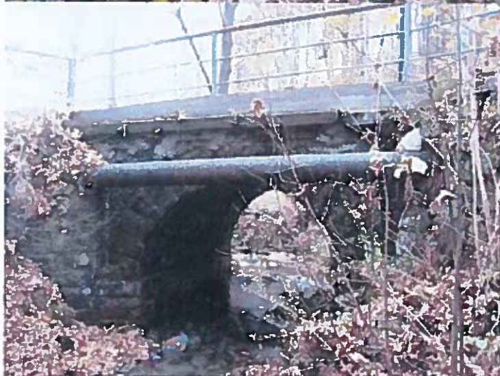
Pohled na čelo na vtoku
