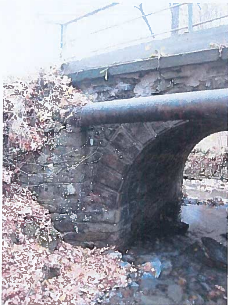
Pohled na levé křídlo na vtoku
