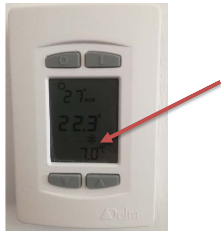
Obr. 2 - Vizualizace stavu otevření okna (7.0°C)
