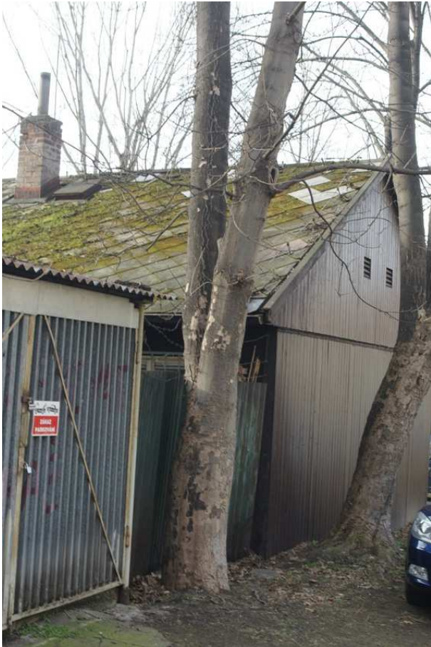
Exempláře Acer pseudoplatanus hodnocené pod čísly 7. a 8., exemplář číslo 7. nevhodné tlakové větvení, exemplář číslo 8. vykloněný směrem do budovy, odhalený kořenový systém, oba exempláře vrůstající do základů budovy
