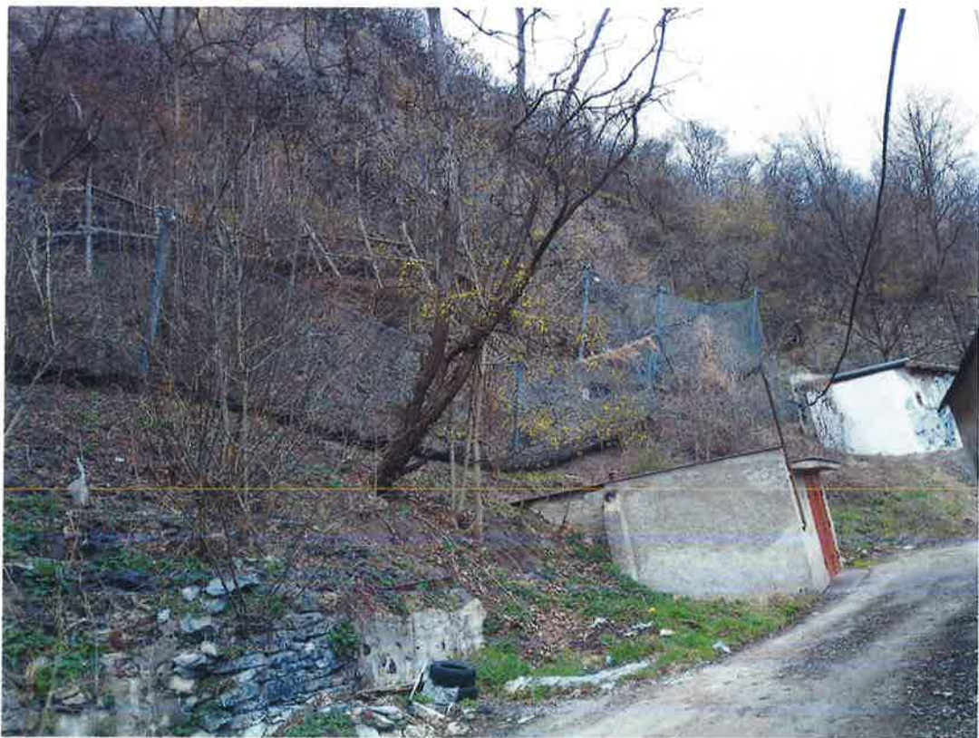
Obrázek 5 Akumulovaný materiál způsobuje prověšení sítě
