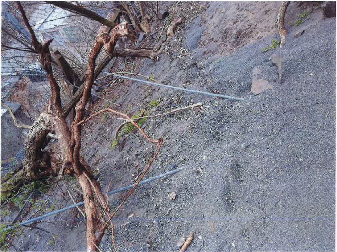
Obrázek 8 Záchytná kotva dynamické bariéry za dočasnou bariérou
