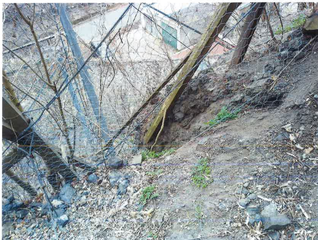
Obrázek 7 Protržení dočasné bariéry
