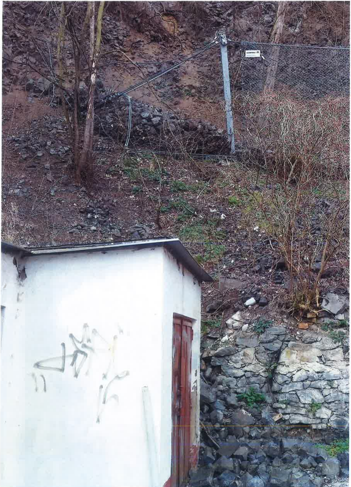
Obrázek 1 naplněná doplňková síť s propadem materiálu ke garážím
