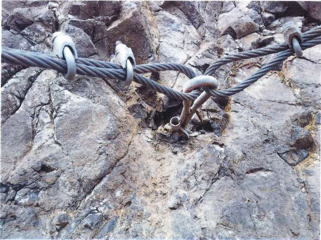
Obrázek 4 hlava kotvy zádržných lan, vyžadována tahová zkouška
