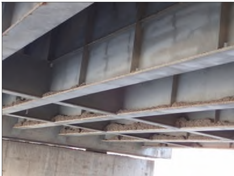
Pole 3, pohled NK, úsek za pilířem P3.
