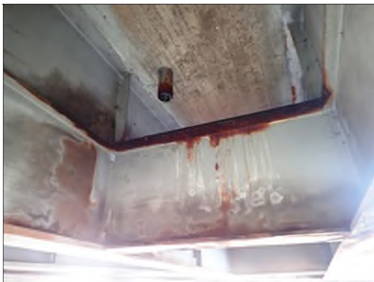
Pole 3, pohled NK, úsek před O4, mezi L krajními nosníky.
