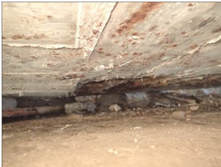
Opěra O1, pohled do mezery mezi úložným prahem a koncovým příčnickem.
