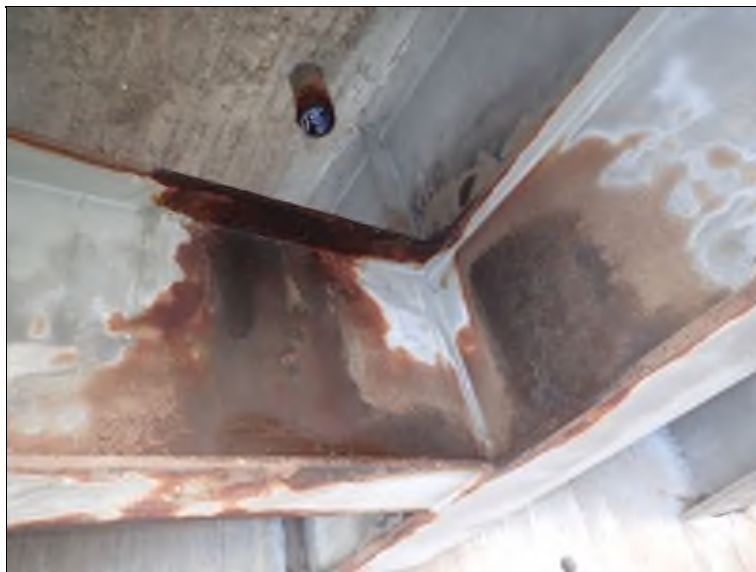
Pole 3, pohled NK, mezi L krajními nosníky, úsek před O4.
