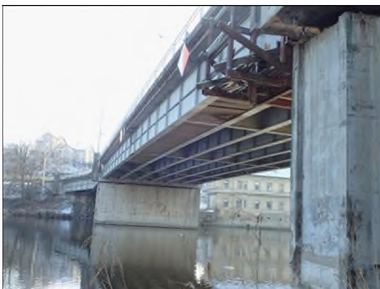
L bok mostu, pole 2, pilíř P3.
