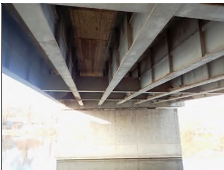
Pole 3, pohled NK, střední část, směrem k P3.
