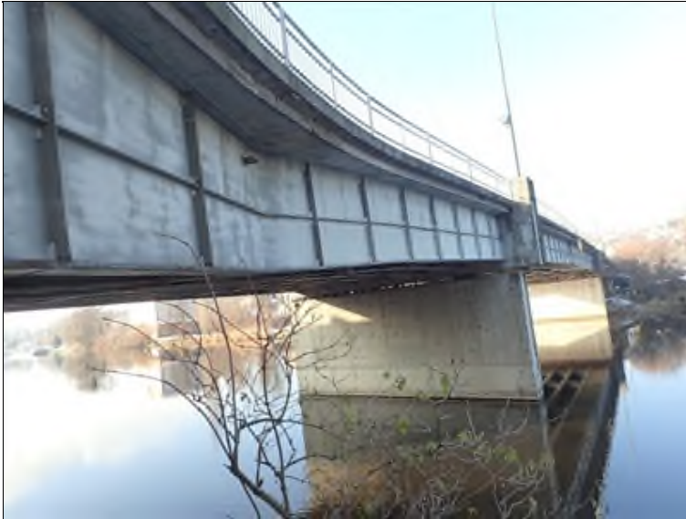
L bok mostu, pole 3, 2, pilíř P3.
