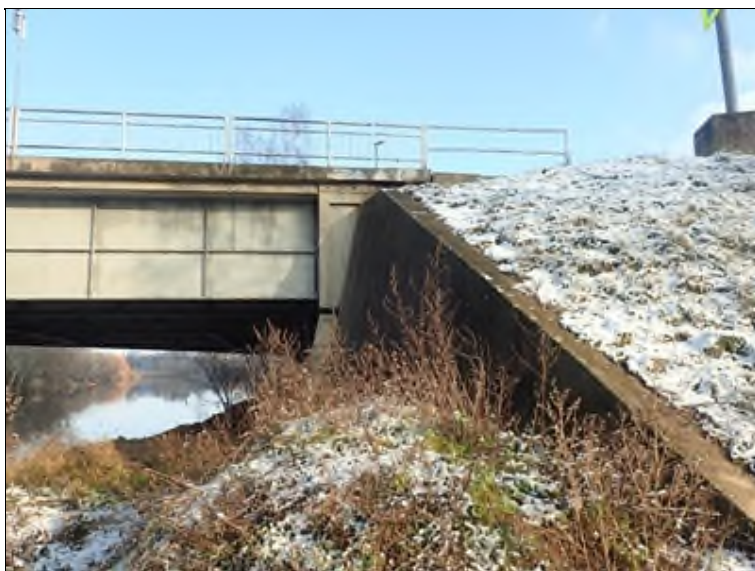
P bok mostu, konec pole 3, opěra O4.
