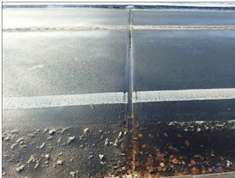
Pohled v linii mostního závěru nad opěrou O1.
