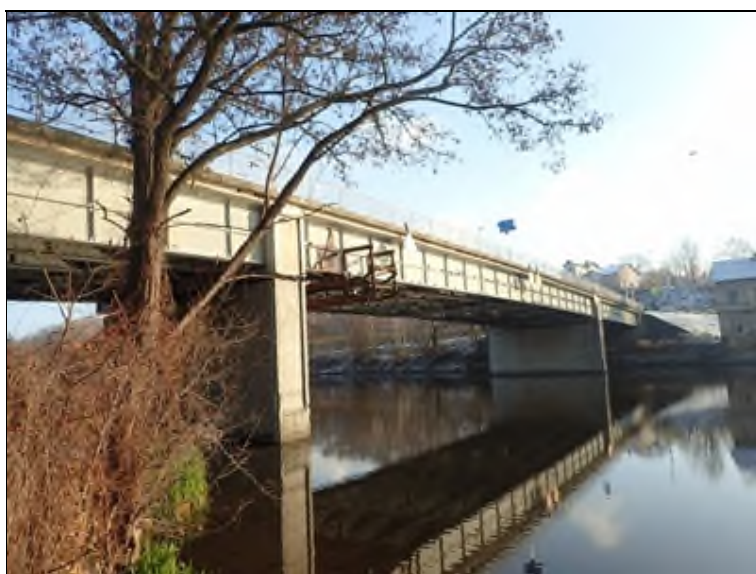
P bok mostu, pole 1, 2, pilíř P2.
