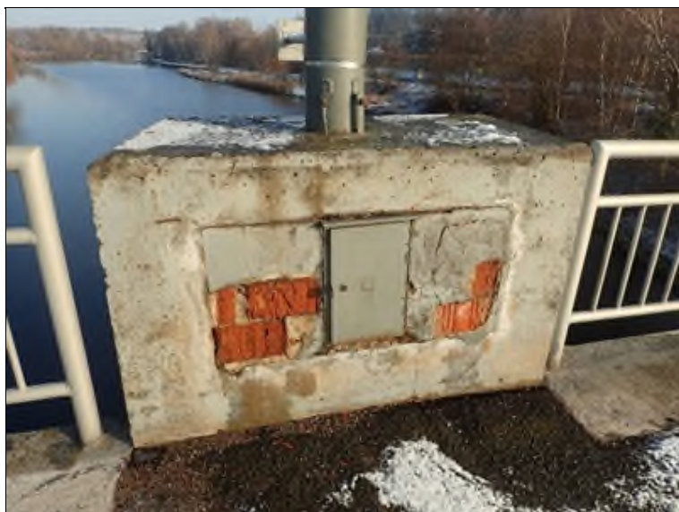
L chodník, parapetní zídka nad P3.
