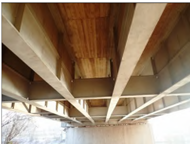
Pole 1, pohled NK, střední část, směrem k P2.
