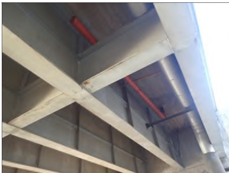
Pole 1, pohled NK, u L boku, úsek před O1.
