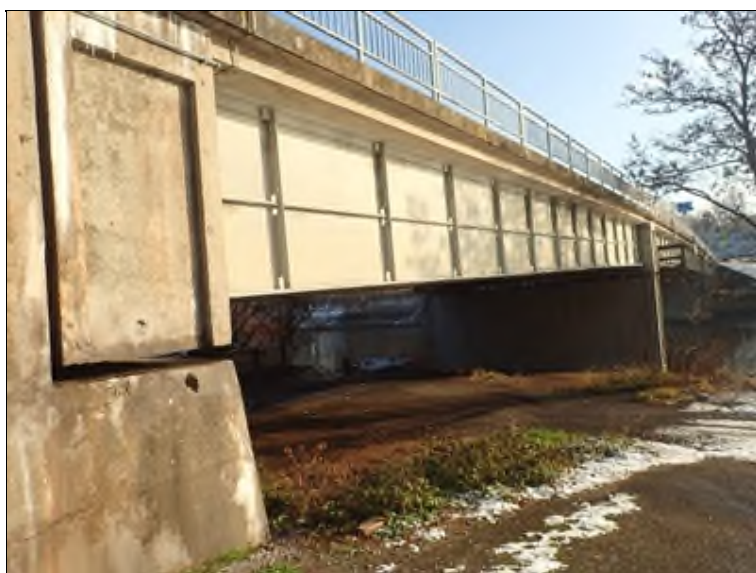
P bok mostu, opěra O1, pole 1.
