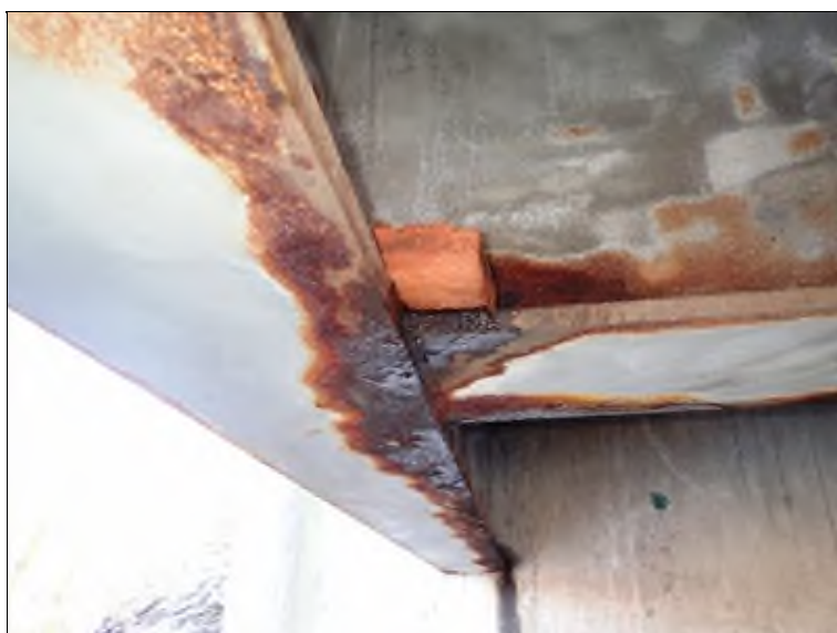
Pole 3, pohled NK, úsek před O4, spodní pásnice L krajního nosníku.
