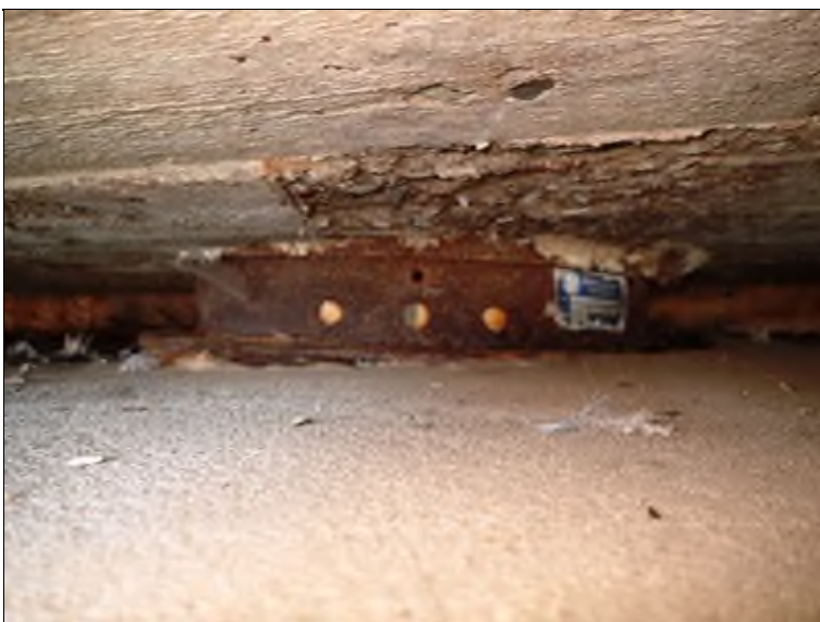
Opěra O4, L ložisko.
