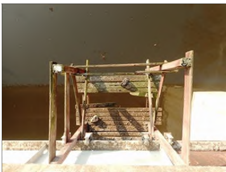
P bok mostu, pole 2, pohled dolů na revizní lávku.
