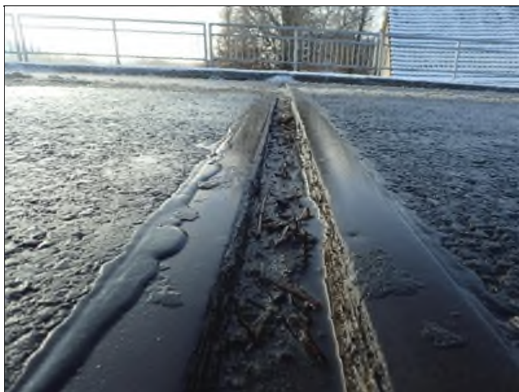
Mostní závěr nad O1, detail přejezdné plochy.
