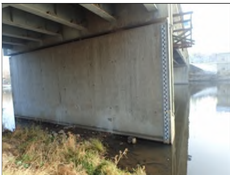
Pilíř P2 z P strany mostu.
