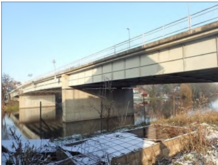
P bok mostu, pole 2, 3, pilíř P3.
