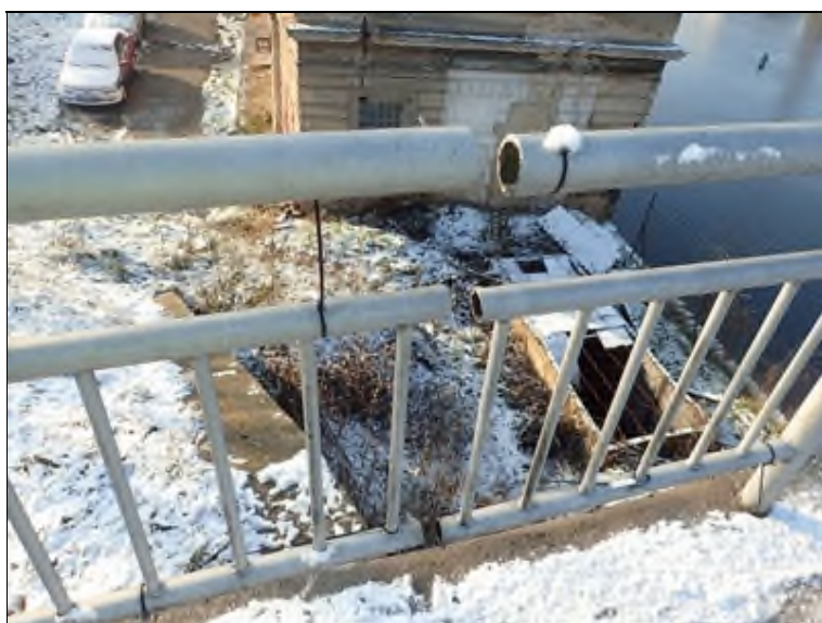
Detail dilatační mezery P zábradlí nad O4.
