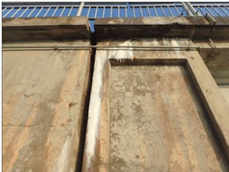
P bok O1, pohled vzhůru k římsě, dilatační spára za koncem NK.
