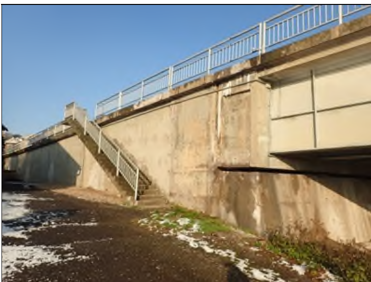
P bok opěry O1 + navazující opěrná zeď + přístupové schodiště.
