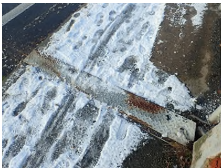
Mostní závěr nad O1, L chodníkový úsek.
