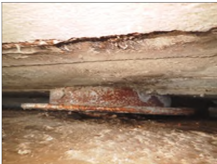
Opěra O1, P ložisko.
