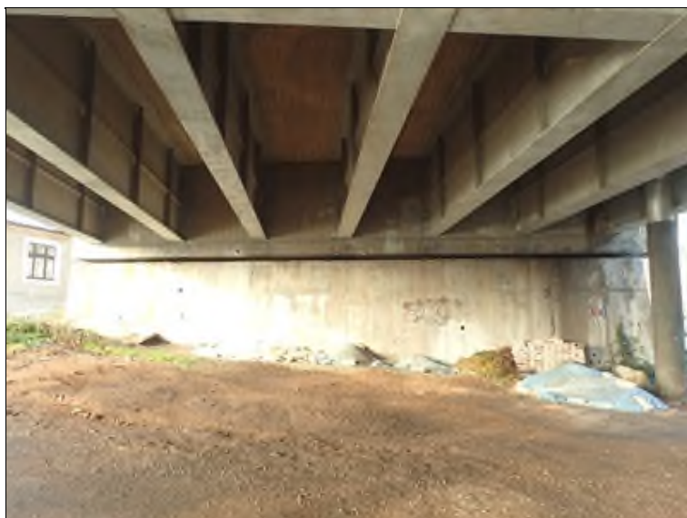
Líc O1, podhled NK v poli 1.
