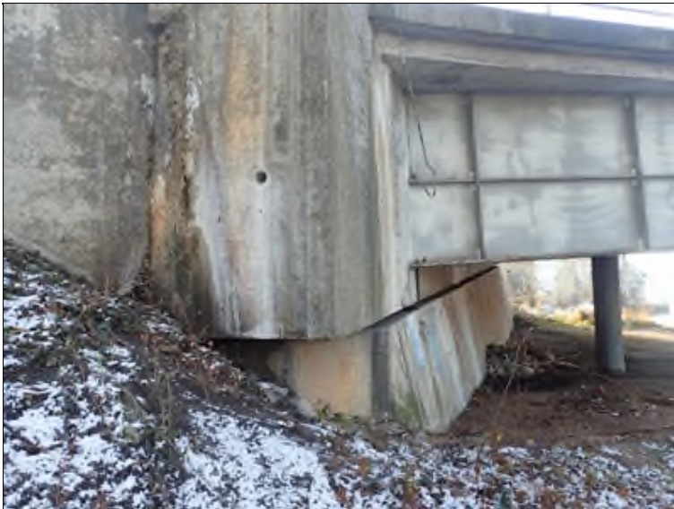
L bok mostu, konec pole 3, opěra O4.
