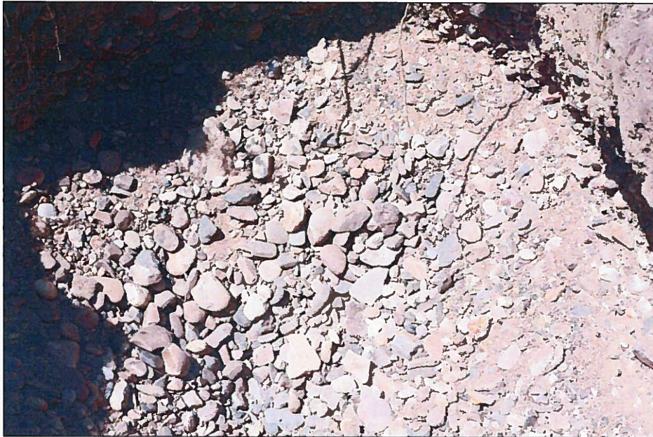
Obr. 3 Pohled do výkopu ve štěrkopiscích s kameny velikosti 15 – 20 cm.
