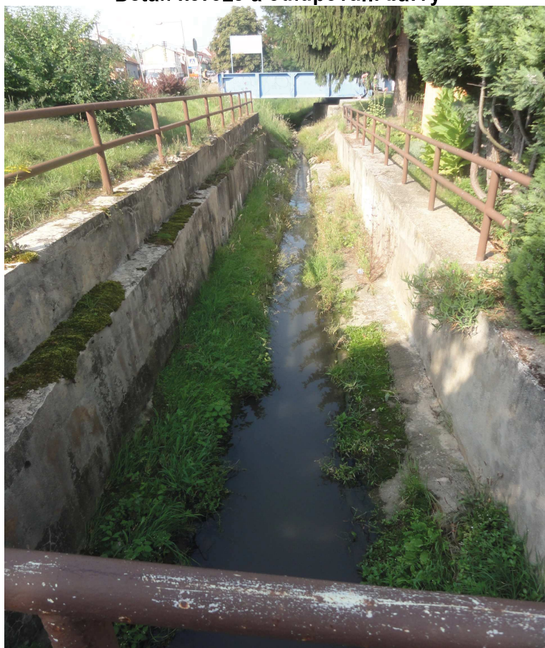
Konec úseku zábradlí u modrého cestního mostu
