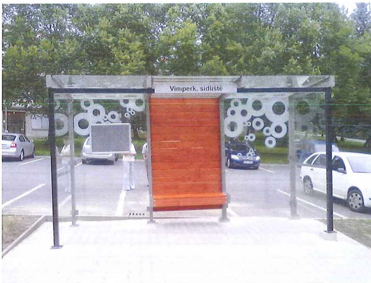
Realizace přístřešku AZC 3M
