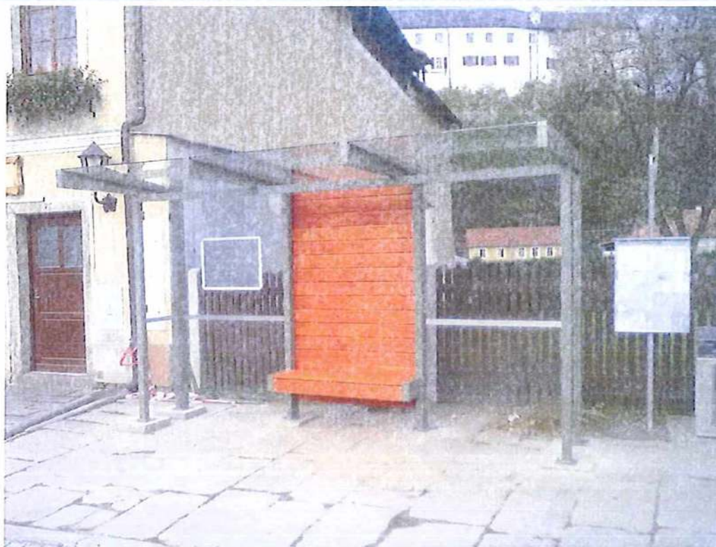
Realizace přístřešku AZC 3M
