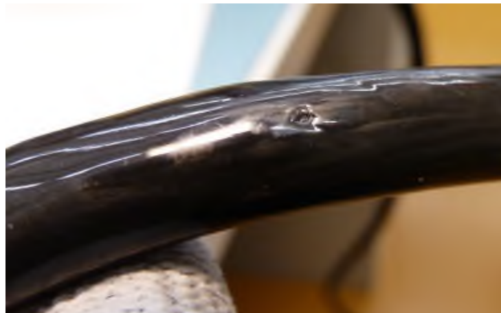
Obrázek 63: Poškozený kabel motoru
