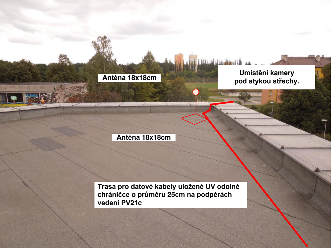
10. Střecha budovy - umístění výložníku pro kameru
