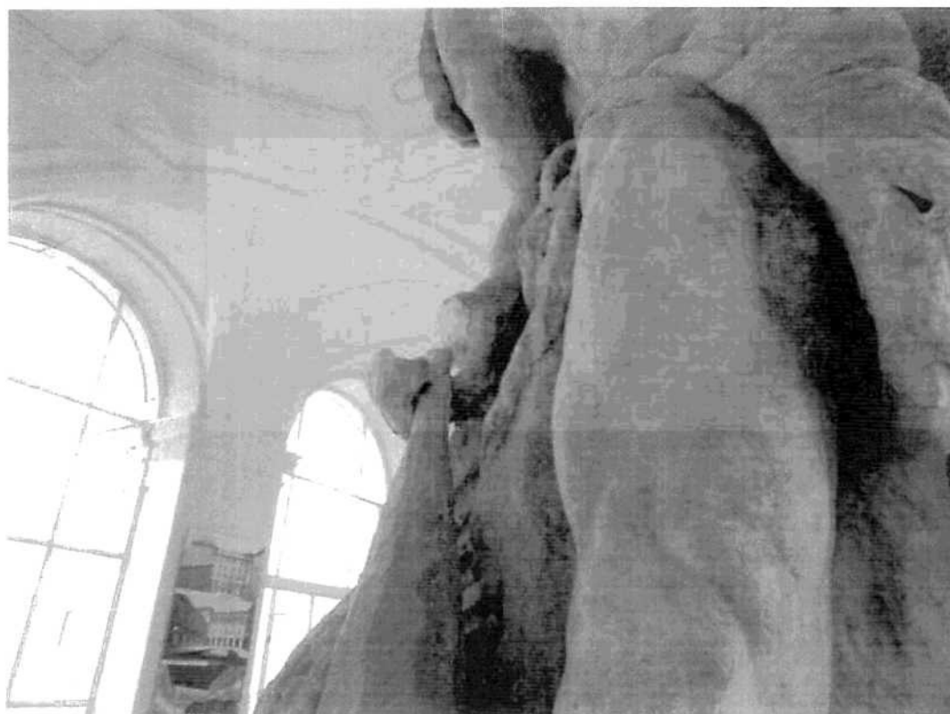
Praha 1 – Hradčany, Černínský palác, socha Herkula – detail poškození pravé ruky
