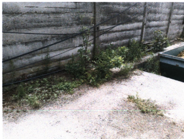
Obrázek 2: Svěšené kabely bez krytí
