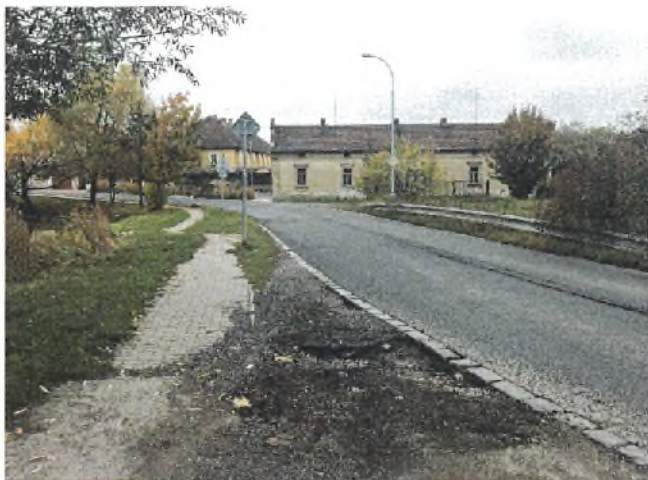
Ukončení pásu mezi chodníkem a silnicí.
