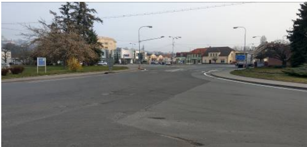
Křižovatka č.2, křížení silnic č. II/272 a II/610 – po změně dopravního režimu zachována jako styková
