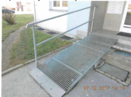
Obr. 6 příklad nájezdová rampa + zábradlí exteriér
