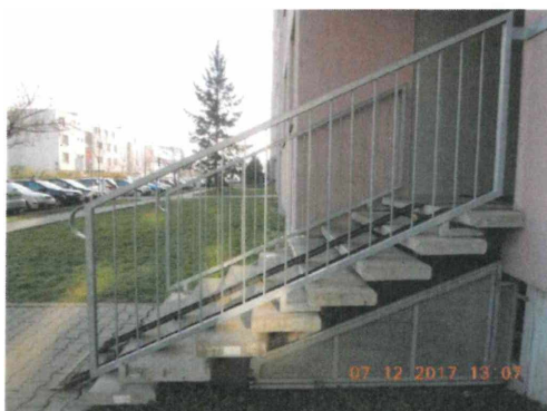
Obr. 7 – příklad zábradlí u vstupu do BD exteriér
