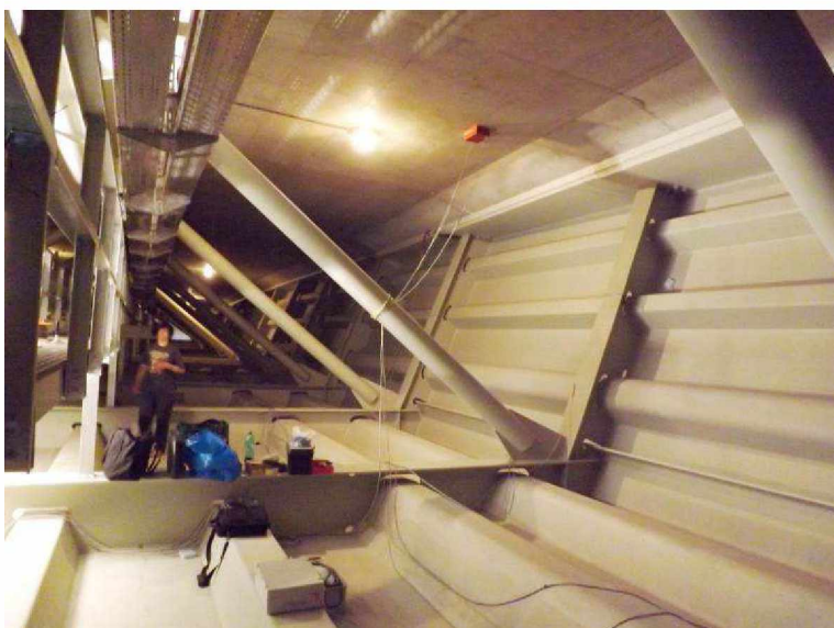
Pravá polovina dutiny mostu
