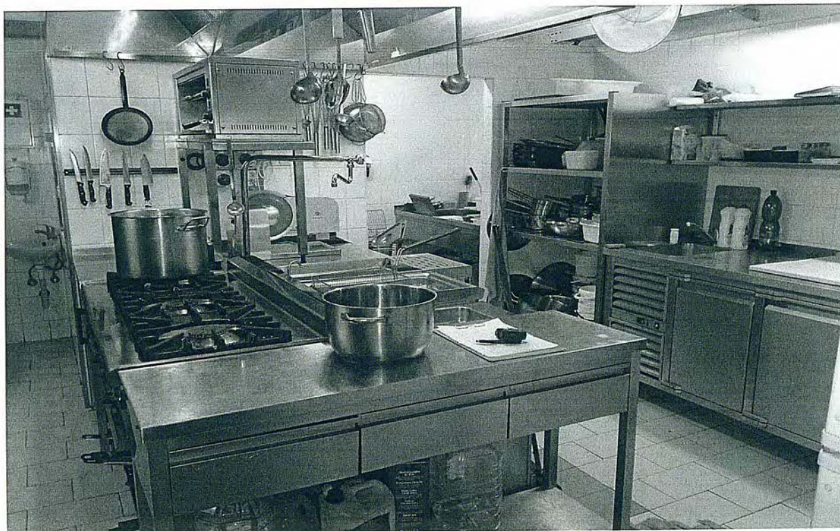
Varný blok. Kuchyně Kodaňská 5, Praha 10
