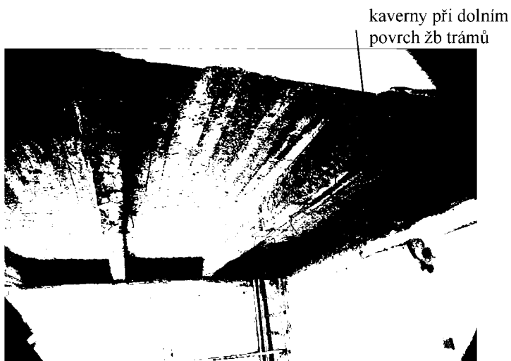
Obr.foto 4) Pohled na žb konstrukci - stropu nad přízemím stávajícího objektu
