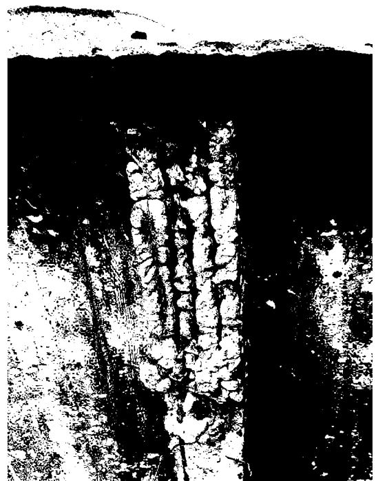
Obr.foto 5-6) kaverny při dolním povrch žb trámů - DETAILY
