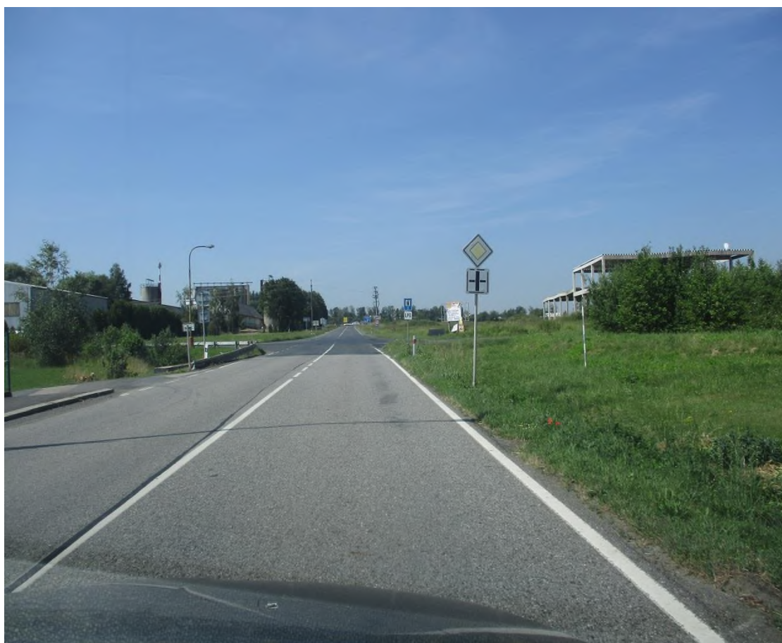
II/150 – průtah částí obce v Brzoticích (úpr. č. 7 a 8)
