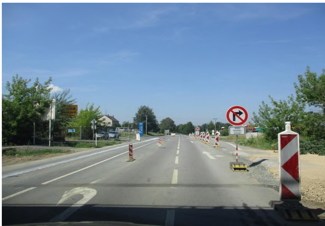
Místo budoucí OK na sjezdu z D1 od Prahy (úpr. č. 3)
