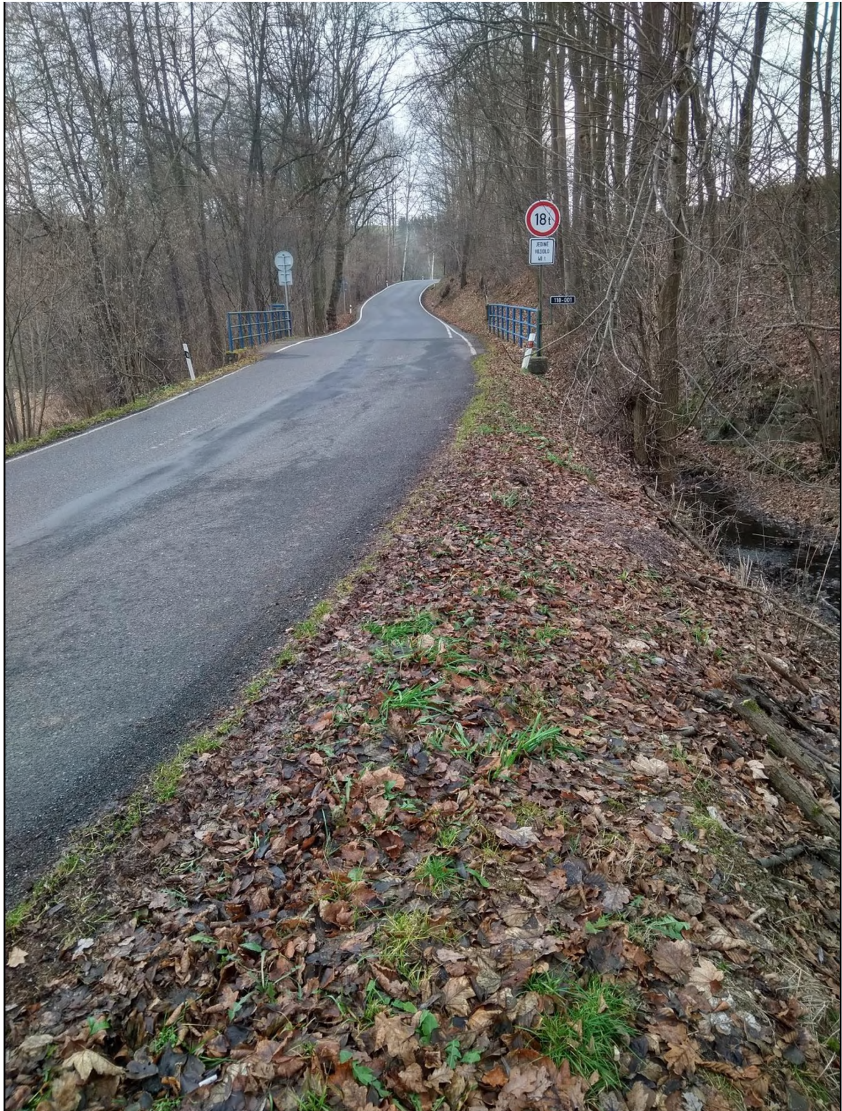
Obrázek 4 Úsek před a za mostem 118-001 (pohled proti směru staničení)
