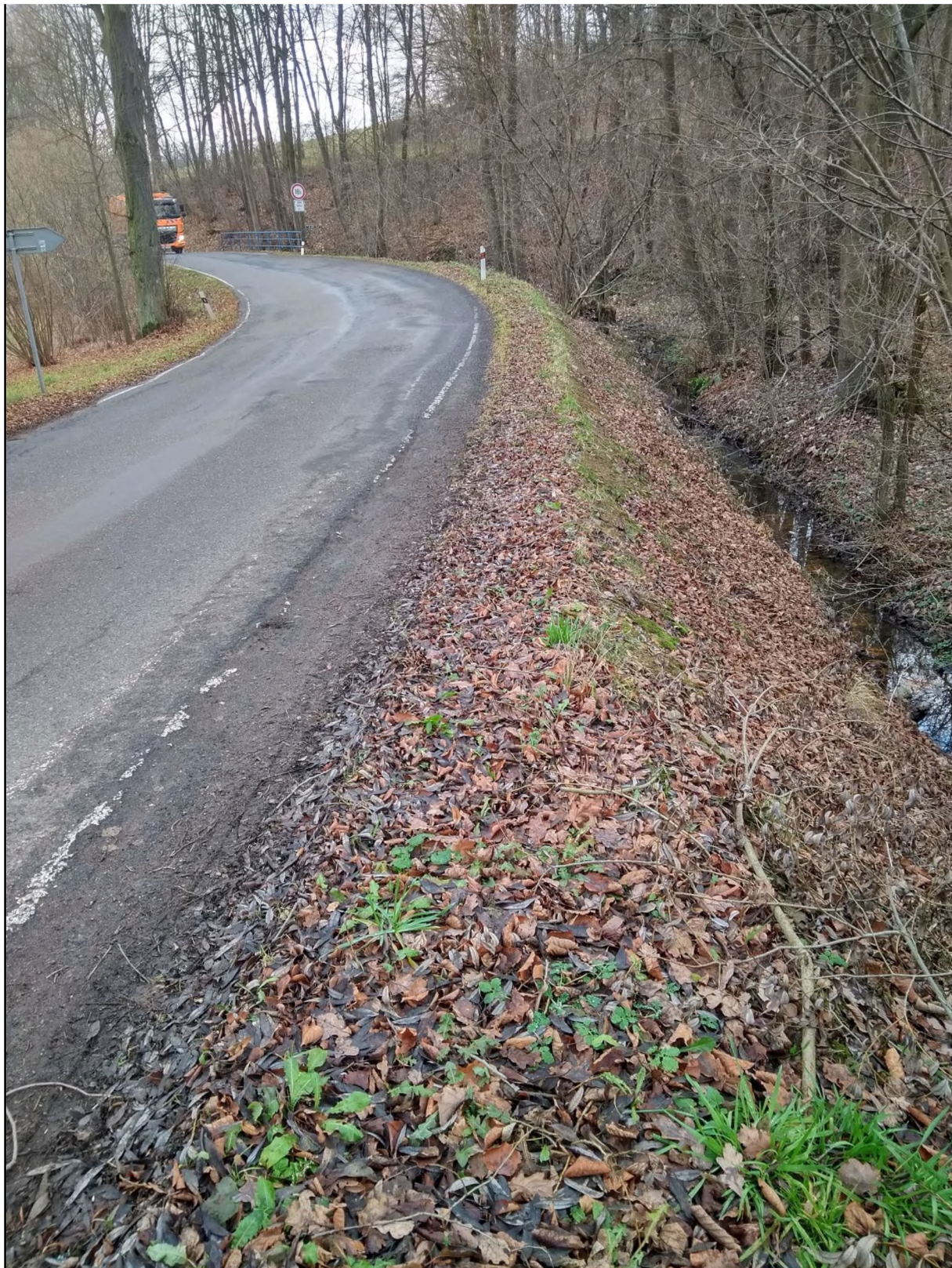
Obrázek 3 Pohled na zatáčku za mostem (pohled proti směru staničení)
