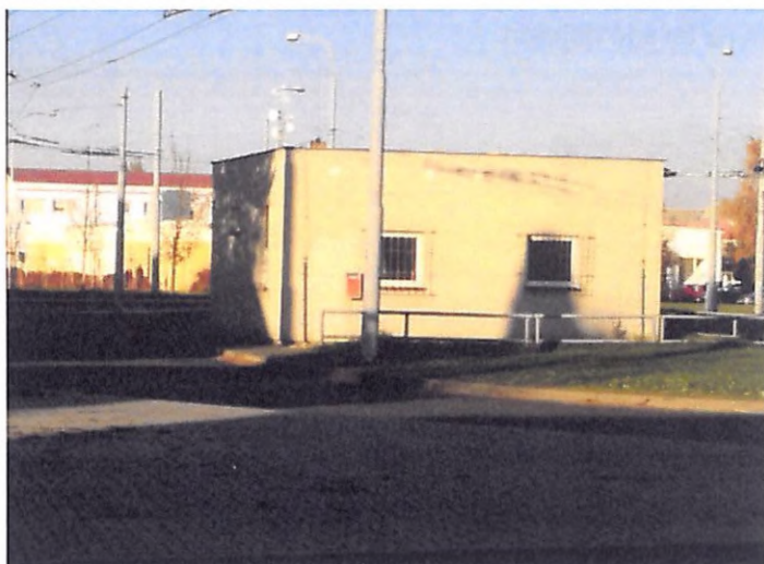
Pohled z ulice Dopravní x K Lesu
