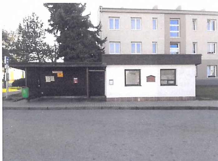
Pohled z Prvomájové ulice
