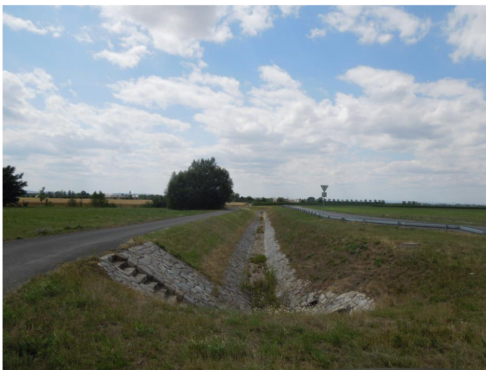
Kanál dešťových vod – východní strana
