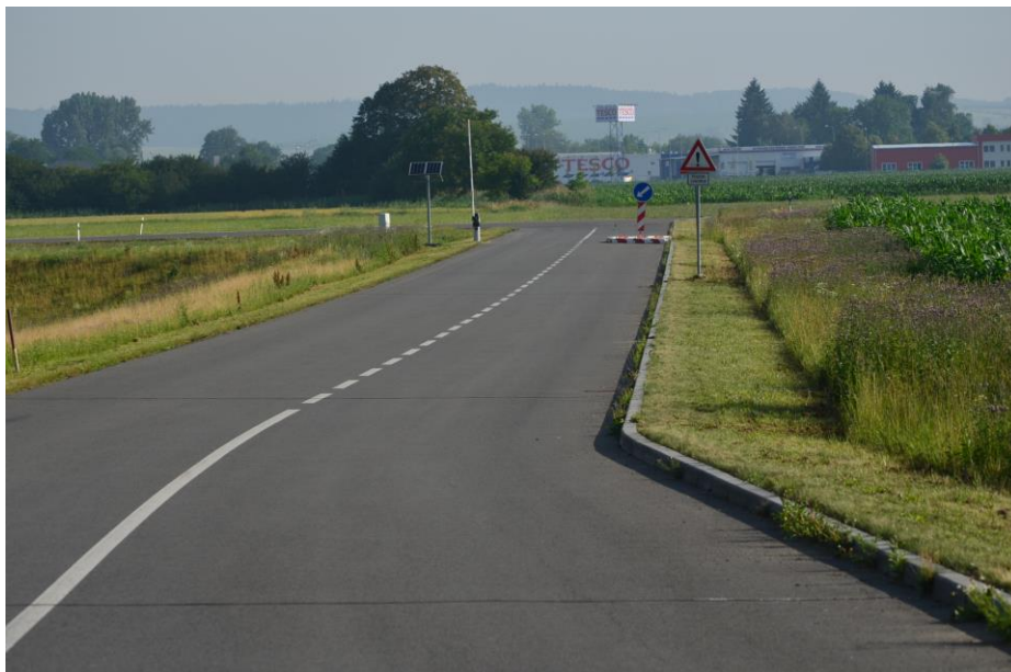
Komunikace jih – podél východní hrany poldru
