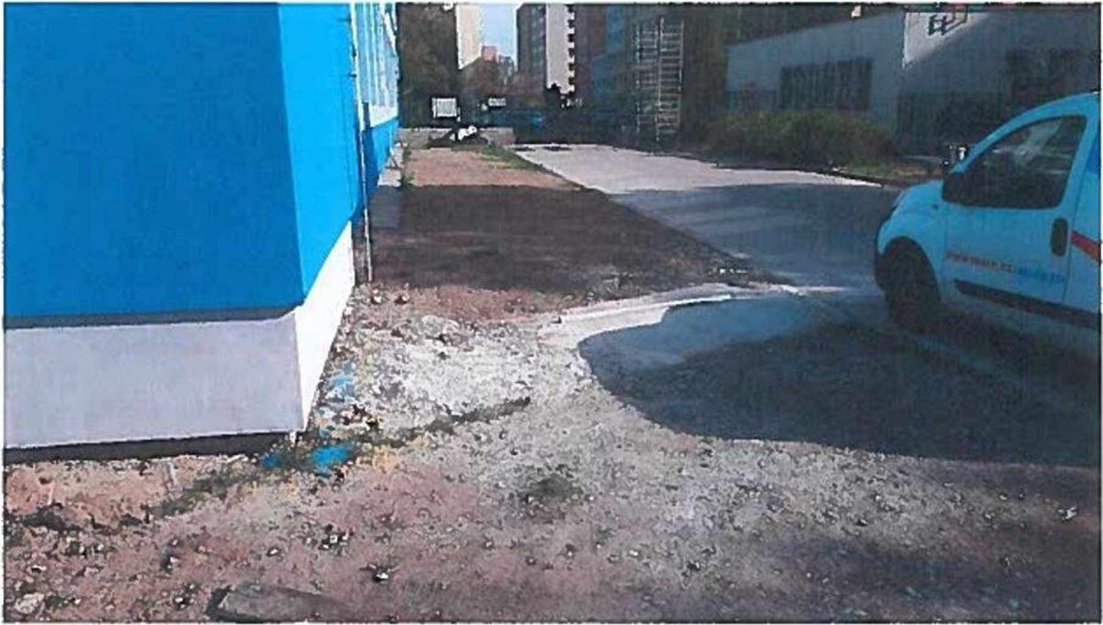
Stávající betonový chodník
