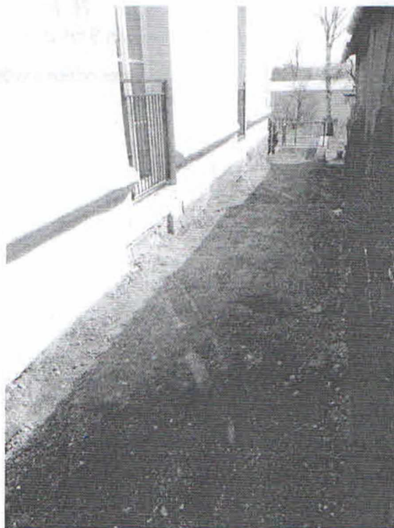
Obr. č. 1 – Úprava terénu a nové zábradlí u francouzských oken
