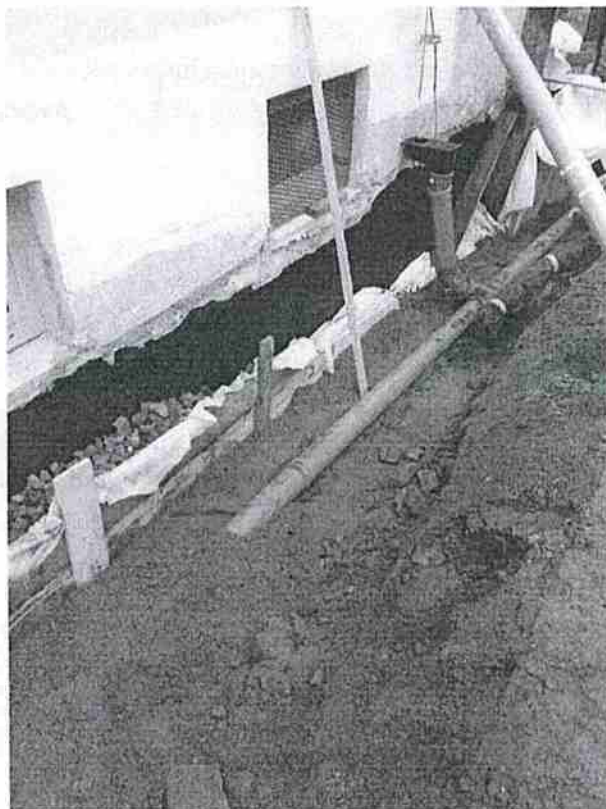
Obr. č. 3 – Nová dešťová kanalizace
