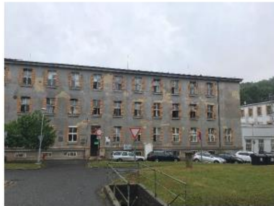
Foto č. 2 - Jižní průčelí
