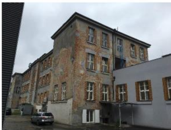
Foto č. 3 - Severozápadní nároží
