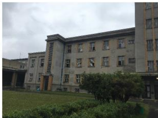
Foto č. 6 - Východní průčelí
