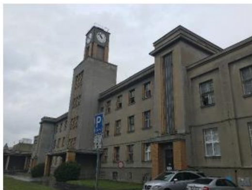
Foto č. 5 - Východní průčelí
