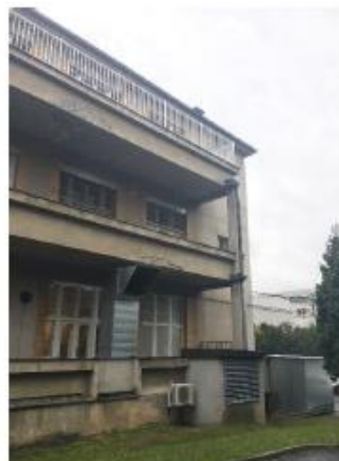
Foto č. 6 – Východní průčelí
