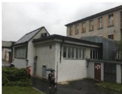
Foto č. 2 - Jihozápadní nároží
