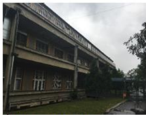
Foto č. 4 - Východní průčelí
