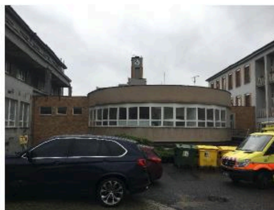
Foto č. 6 - Jižní průčelí
