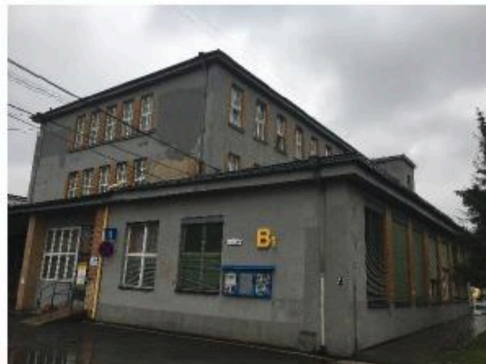
Foto č. 2 - Severozápadní nároží
