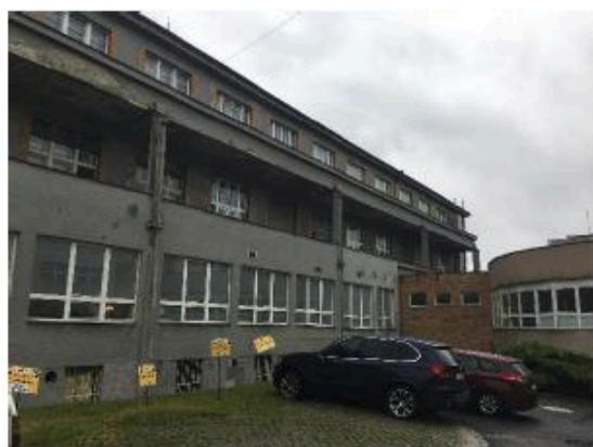
Foto č. 5 - Východní průčelí
