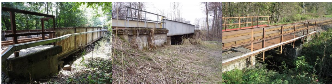
Obrázek 1: mosty v evid. km 1,123; 2,573; 5,702
