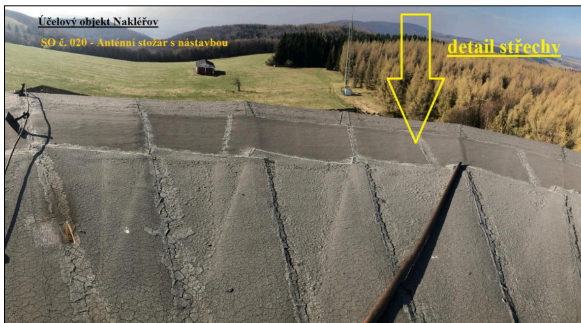
Foto č. 2 – Anténní stožár s nástavbou – detail střechy (pohled z výstupního otvoru na střeše)
