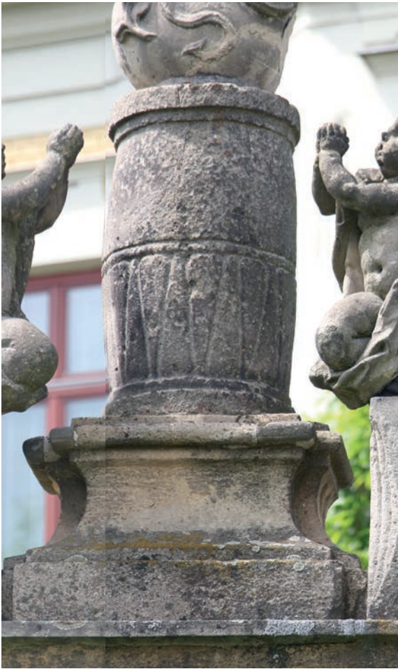
Obr. č. 25: Profilovaná patka a dřík sloupu sochy Panny Marie. Znečištění povrchu, boiologické napadení, různorodé starší dožívající tmely s nevhodnou barevností a strukturou.
