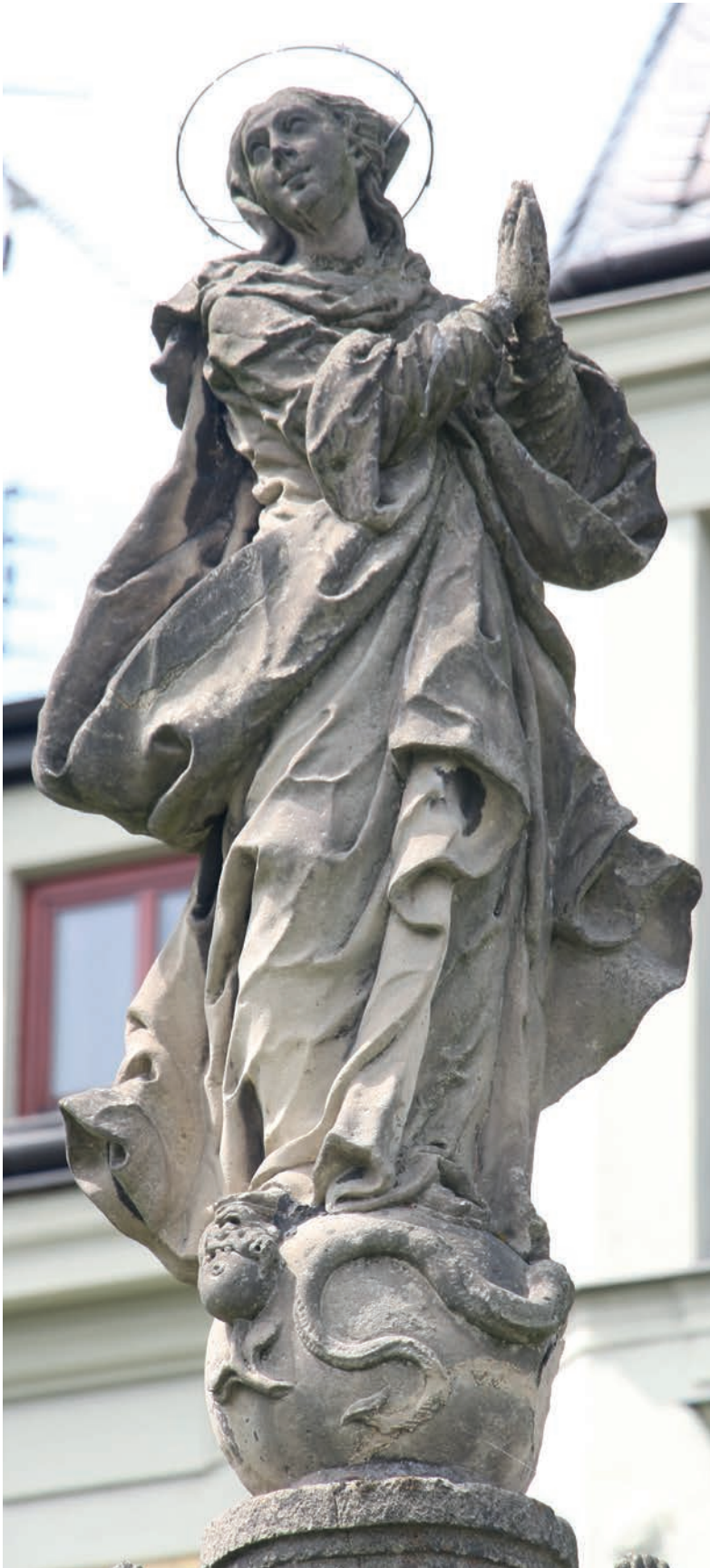
Obr. č. 5-6: Skulptura Panny Marie zhotovená v dílně sochaře Filipa Sattlera. Silné sádrovcové krusty v dešťových stínech, biologické napadení, tmavé nečistoty a silikátový film na exponovaných plochách, hloubkové trhliny, dožilé starší tmely.
