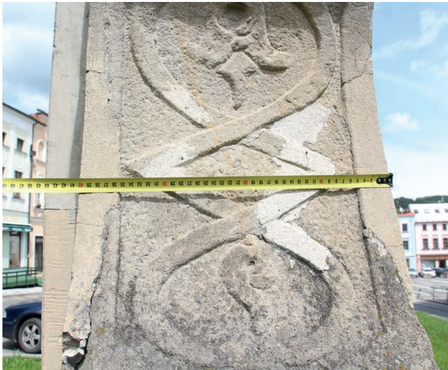
Obr. č. 13: Boční strana volutového náběhu středního bloku podstavce. Zvětrání kamene, znečištění a biologické napadení, praskliny v kameni, různorodé starší dožívající tmely s nevhodnou barevností a strukturou.
