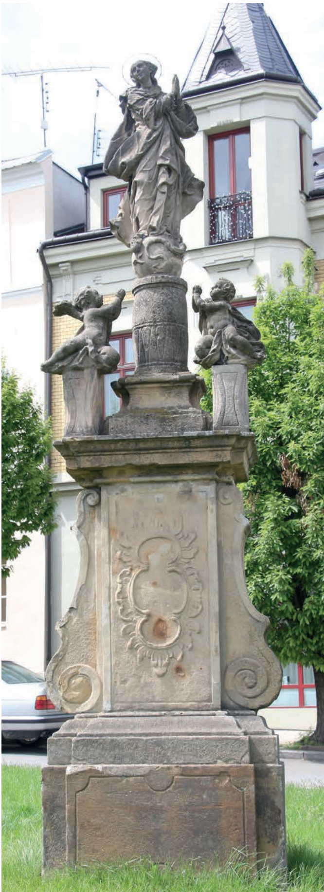
Obr. č. 1: Čelní pohled na památku.
