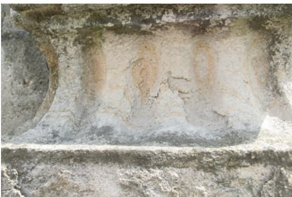
Obr. č. 26: Profilovaná patka sloupu sochy Panny Marie ze zadní strany. Silná degradace a zvětrání kamene v oblasti profilace kanelování. Šupinatění a plátkování kamene.
