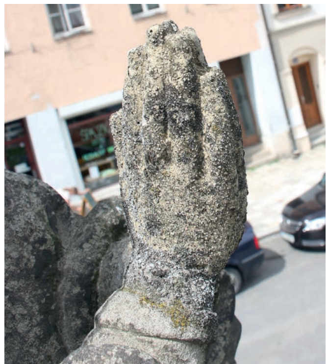
Obr. č. 31-32: Ruce sochy Panny Mari. Sepjaté ruce jsou zhotoveny z umělého kamene. Ten je již dožilý, drolí se a je povrchově zvětralý vlivem biologického napadení a větrné abraze.
