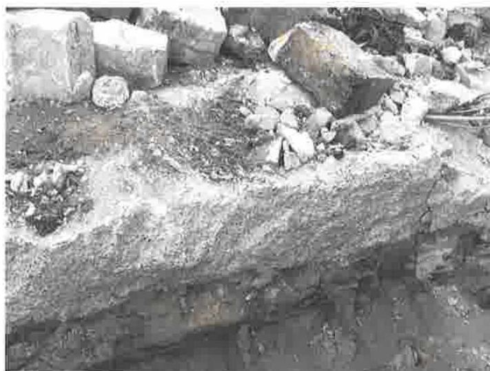
Bourání konstrukcí z prostého betonu – vyrovnávka pod ŽB deskou
