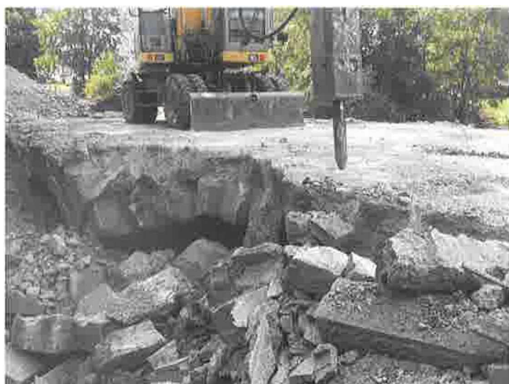
Bourání konstrukcí z prostého betonu – vyrovnávka pod ŽB deskou
