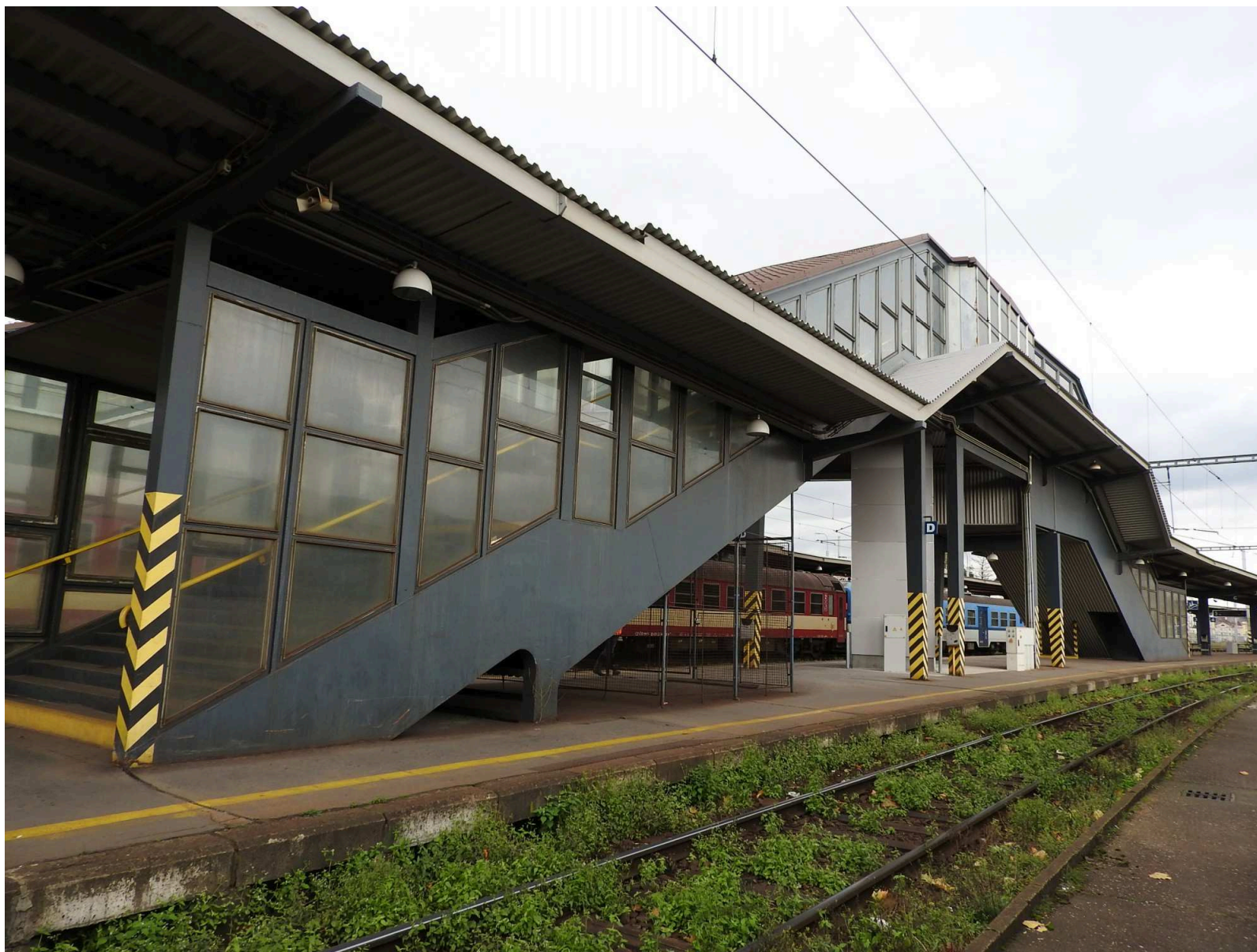
„Oprava mostních objektů v žst. Ostrava hlavní nádraží“, SO 01 lávka km 0,217 (TU 2132, DU A3) pohled proti směru staničení (schodiště, V.nástupiště, kolej č.804 a 803)
