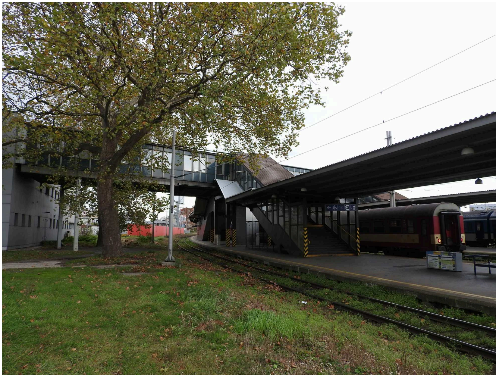
„Oprava mostních objektů v žst. Ostrava hlavní nádraží“, SO 01 lávka km 0,217 (TÚ 2132, DÚ A3) pohled ve směru staničení (tubus lávky + schodiště IV.nástupišť, kolej č.801 a 802)
