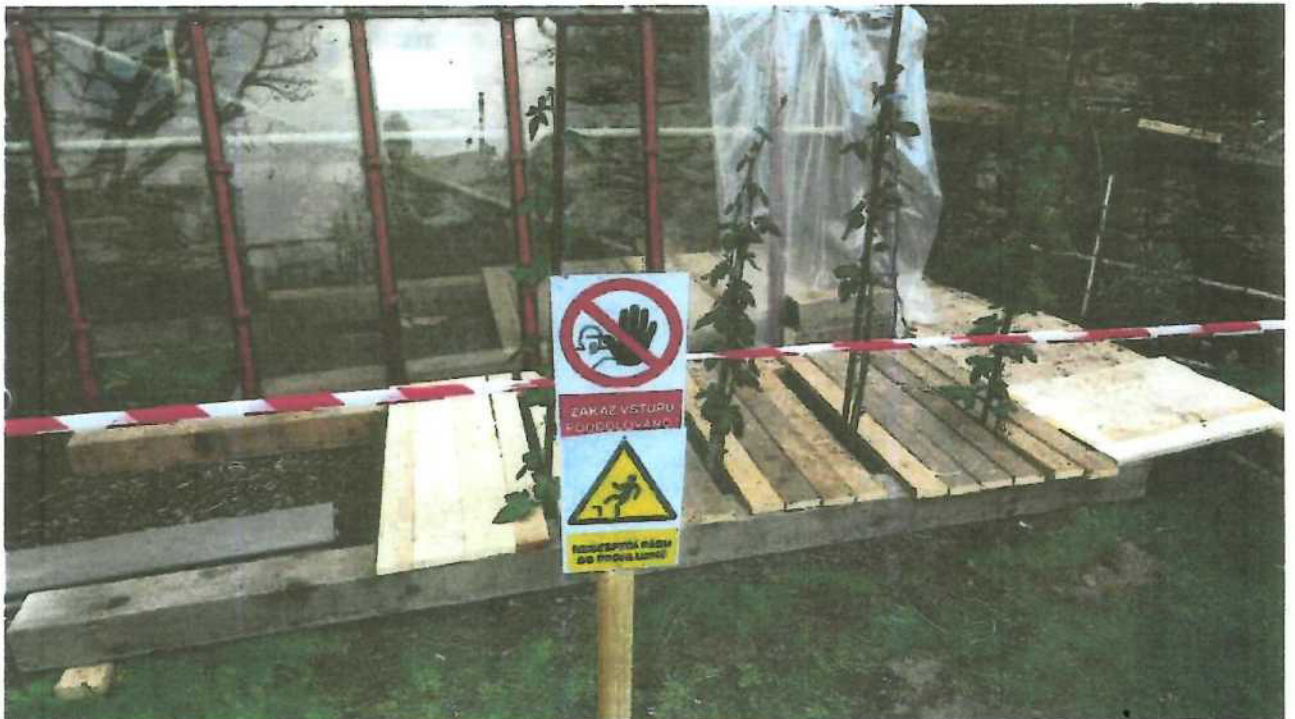
Pohled na ochranný poval a výstražné tabulky
