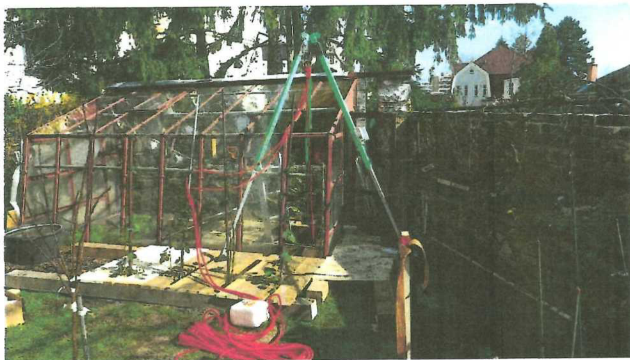
Pohled na ochranný poval a evakuační trojnožku nad propadem
